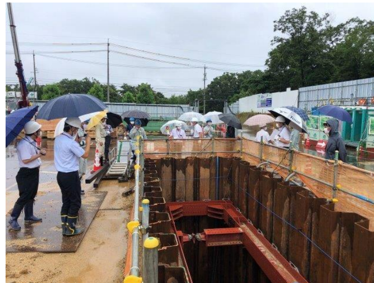
現場説明 3 (緊急遮断弁への流入管)
