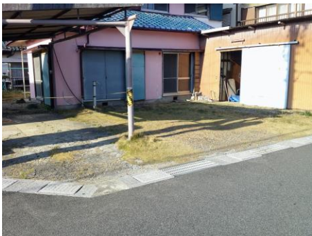
【カーポート・駐車場】
