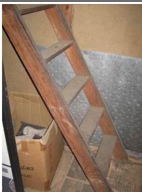
【小屋裏階段 (離れ)】
