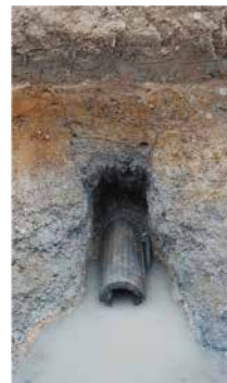
木樋の発見時の状態
