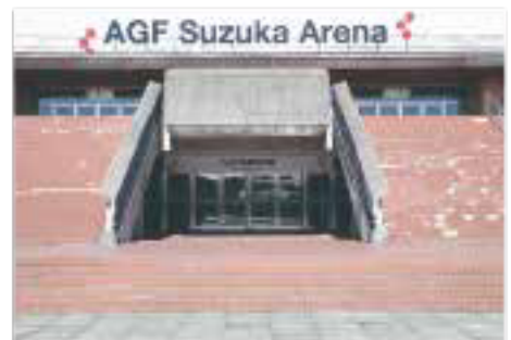
改修中の市立体育館
