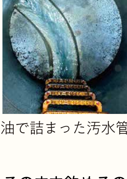
油で詰まった污水管
