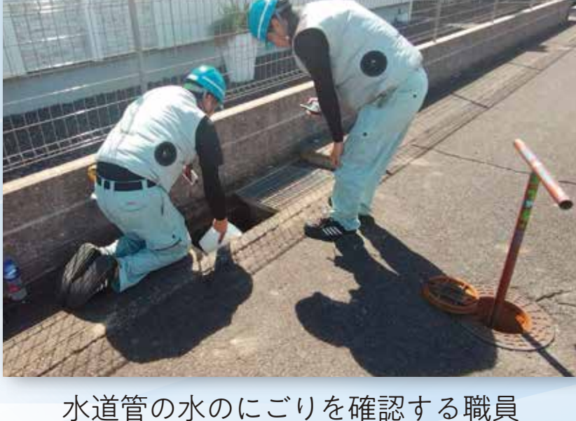
水道管の水のにごりを確認する職員
