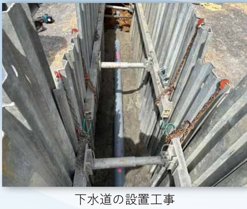
下水道の設置工事
