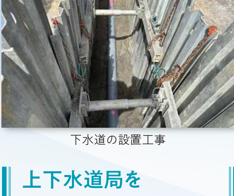
下水道の設置工事
