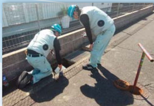
水道管の水のにごりを確認する職員
