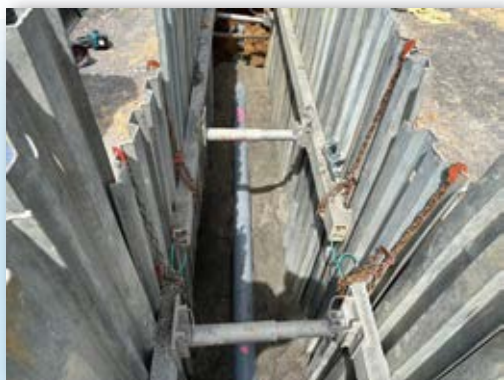
下水道の設置工事
