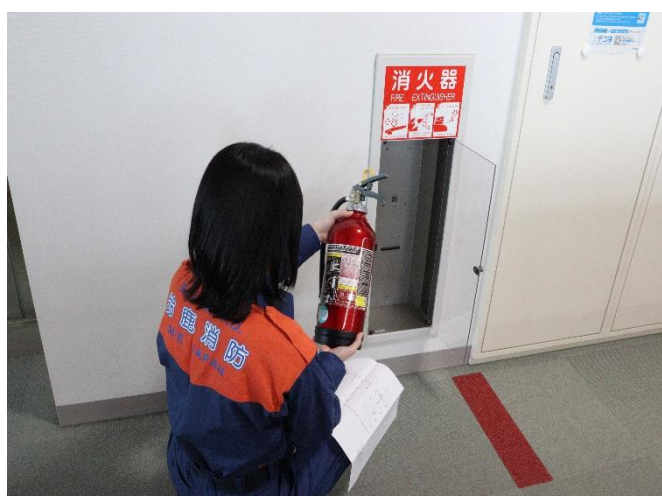
消防用設備検査
