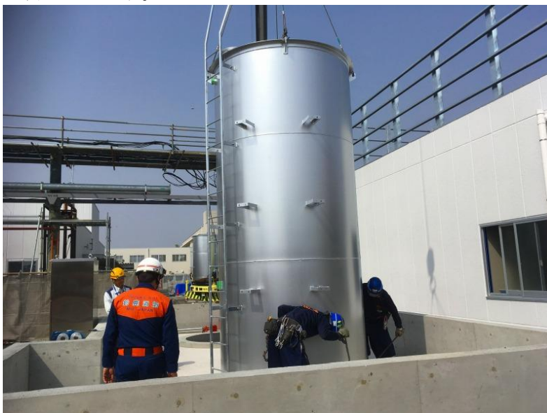
屋外タンク中間検査
