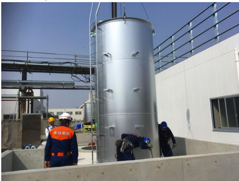
屋外タンク中間検査
