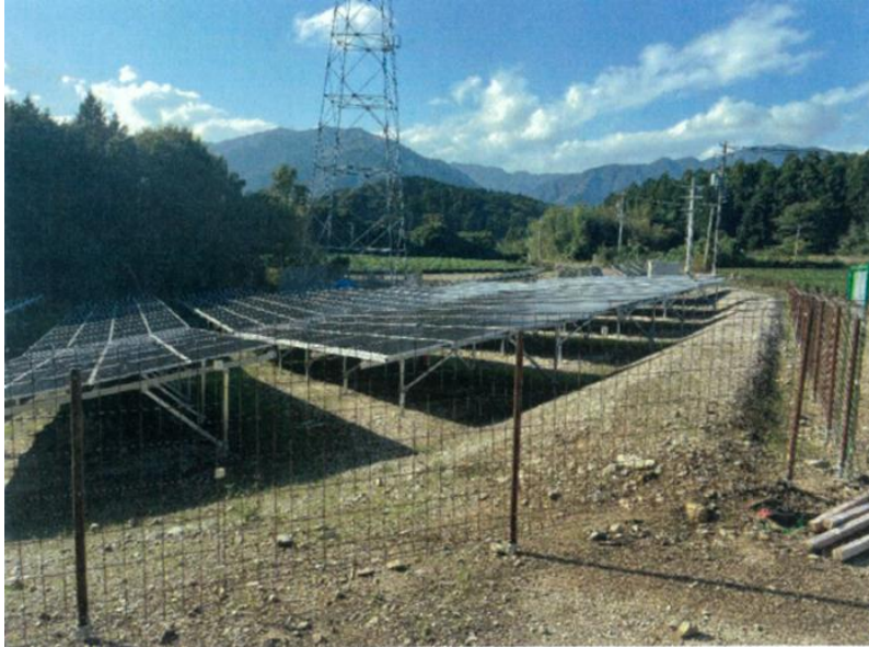
写真：太陽光発電施設
