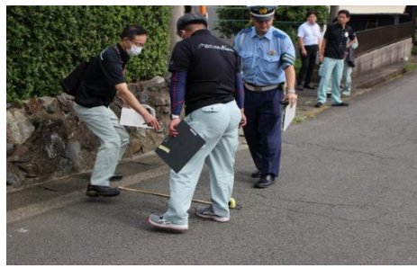
合同危険箇所点検
