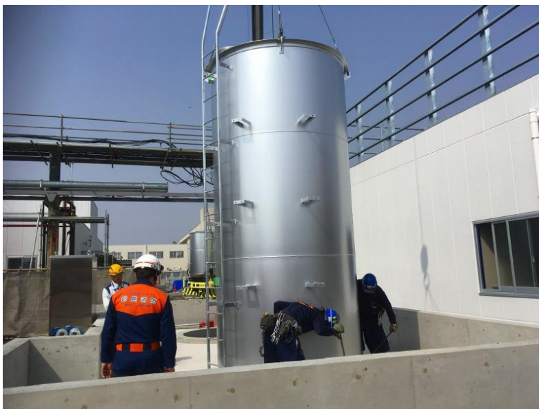
屋外タンク中間検査
