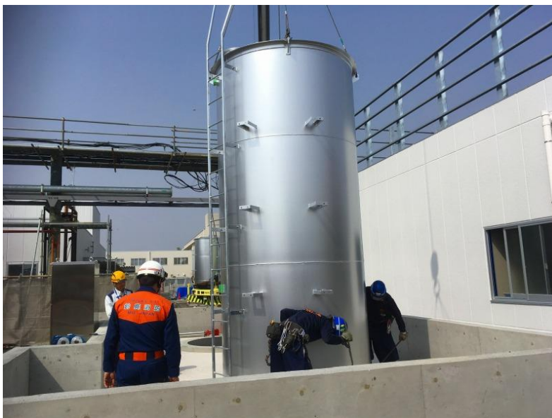
屋外タンク中間検査
