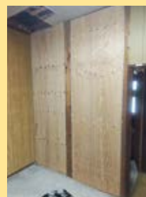
補強後(合板の設置)
