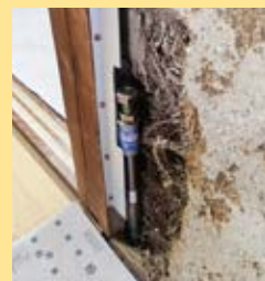
補強後(金具で補強)
