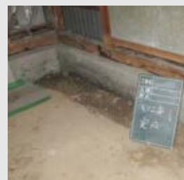
補強後(基礎の打ち増し)
