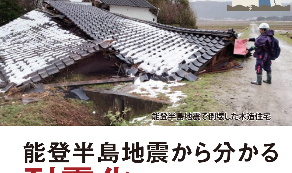
能登半島地震で倒壊した木造住宅
