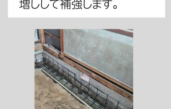
補強後(金具で補強)
