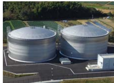
国府第2配水池
