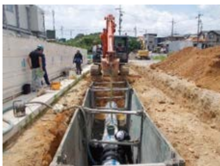
水道管設置状況
