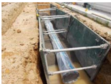
水道管の設置完了
