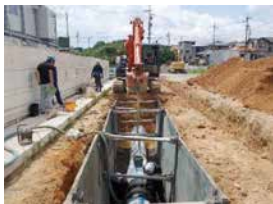
水道管設置状況
