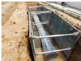
水道管の設置完了
