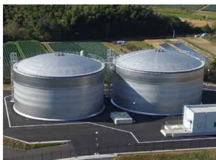
国府第2配水池
