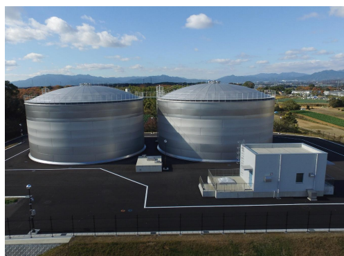
国府第 2 配水池
