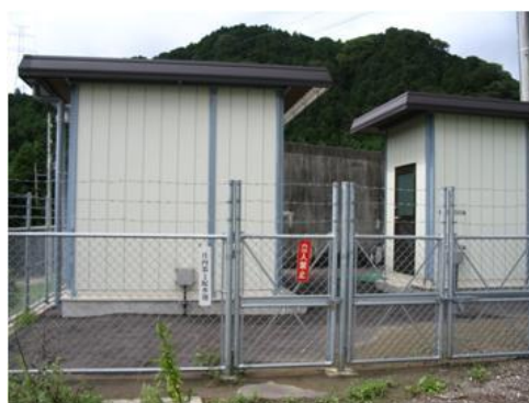
庄内第1配水池
