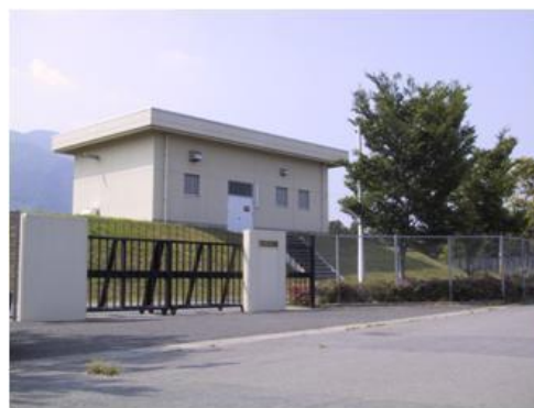
大久保第 1 配水池
