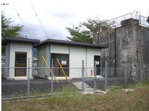
庄内第2配水池
