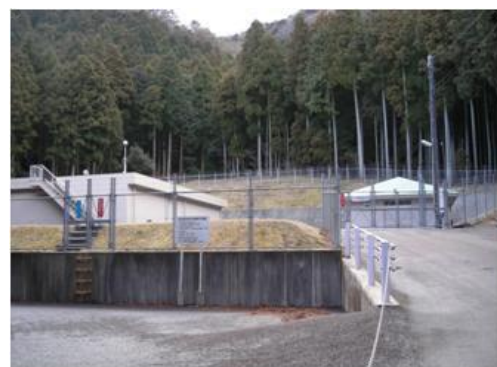
大久保第 2 配水池
