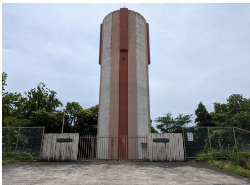
太陽の街配水塔
