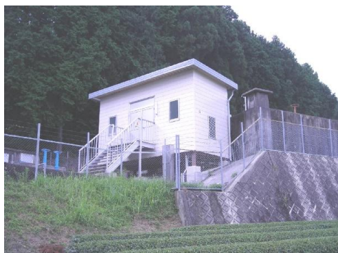
小岐須第2配水池
