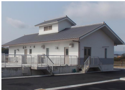
三宅・徳居地区浄化センター
