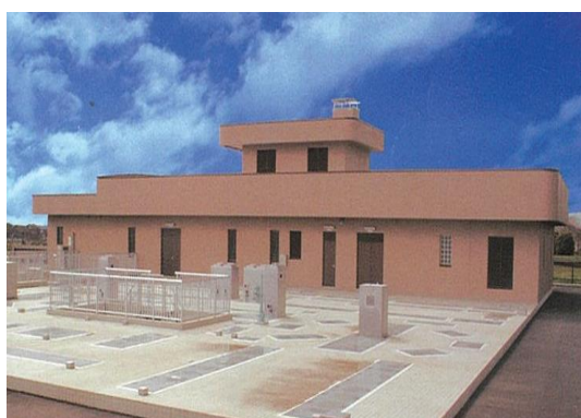
伊船・長澤地区浄化センター
