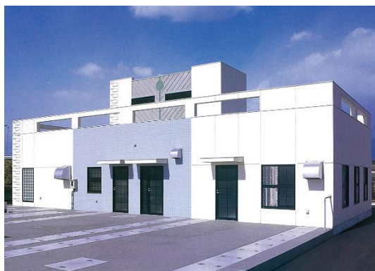
岸田・花川地区浄化センター
