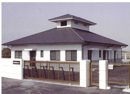
天栄地区浄化センター
