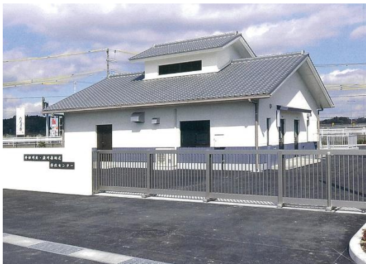
井田川北・汲川原地区浄化センター
