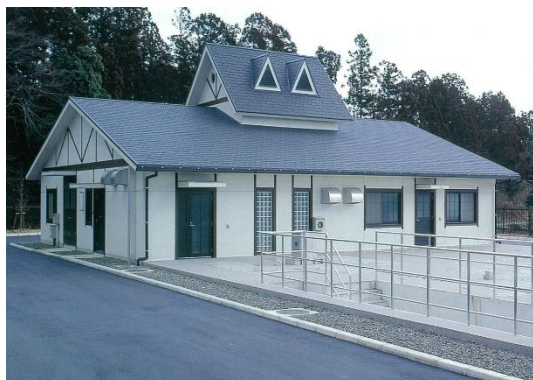
下大久保地区浄化センター
