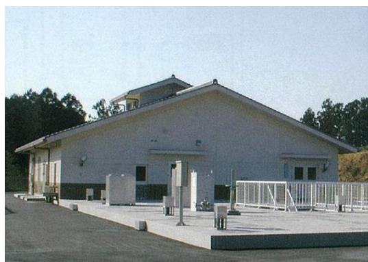
椿地区浄化センター
