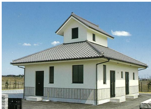
甲斐地区浄化センター
