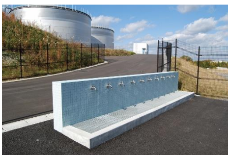
国府第2配水池
