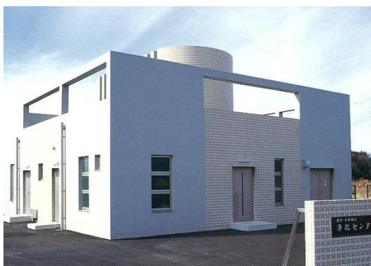
国分・木田地区浄化センター
