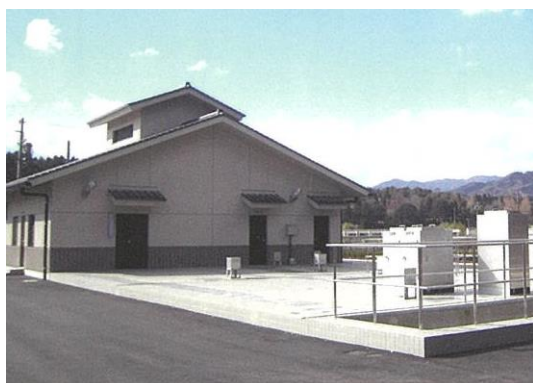
東庄内地区浄化センター
