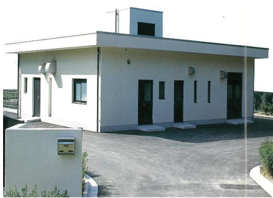
国府地区浄化センター
