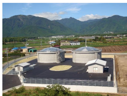
椿 一 宮 配 水 池
