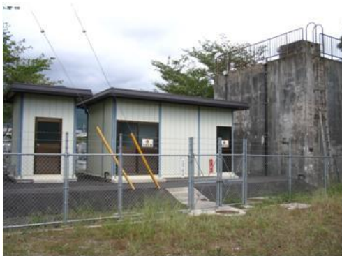
庄内第2配水池
