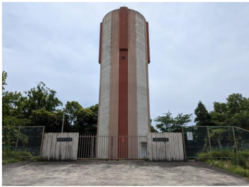
太陽の街配水塔
