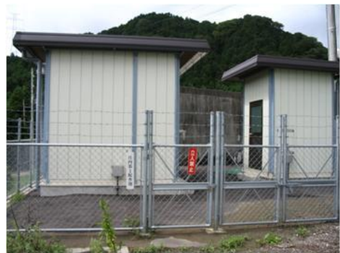
庄内第1配水池
