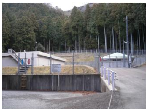
大久保第 2 配水池
