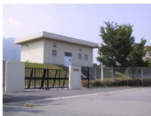
大久保第 1 配水池
