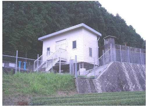
小岐須第1・第2配水池
