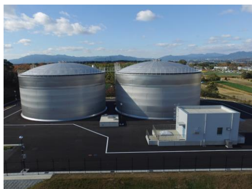
国府第 2 配水池
