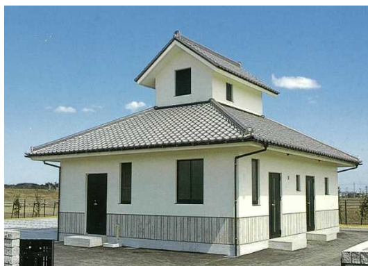
甲斐地区浄化センター
