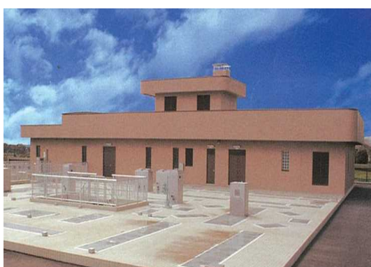
伊船・長澤地区浄化センター
