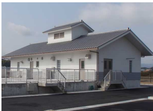
三宅・徳居地区浄化センター
