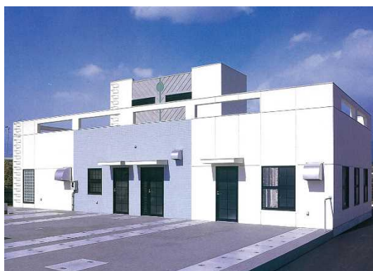
岸田・花川地区浄化センター
