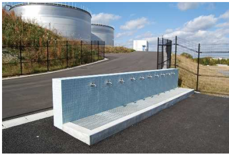
国府第2配水池
