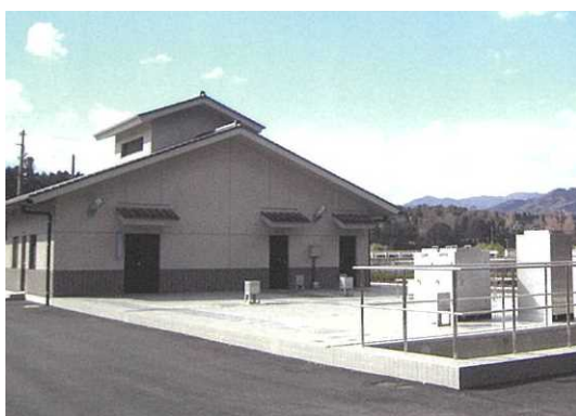
東庄内地区浄化センター
