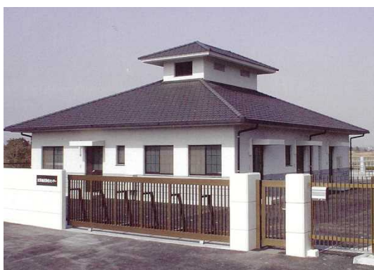
天栄地区浄化センター
