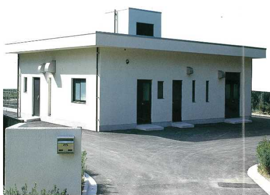
国府地区浄化センター
