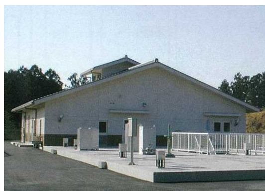
椿地区浄化センター
