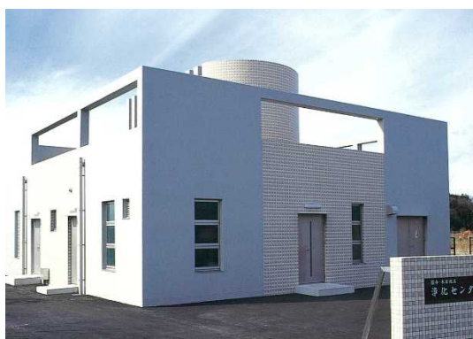
国分・木田地区浄化センター
