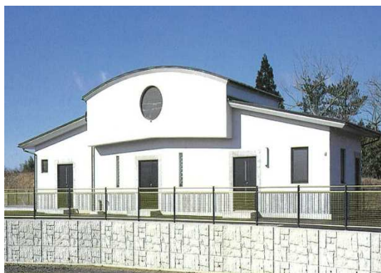
合川地区浄化センター
