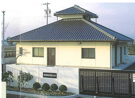
深溝地区浄化センター
