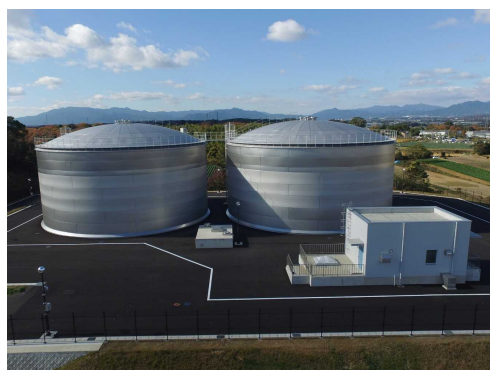
国府第2配水池
