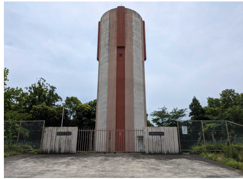
太陽の街配水塔
