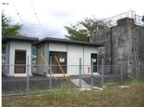
庄内第2配水池
