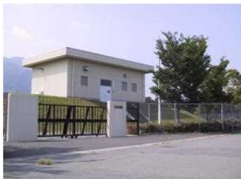
大久保第1配水池
