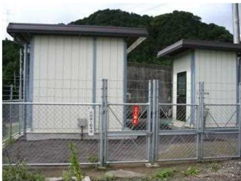
庄内第1配水池
