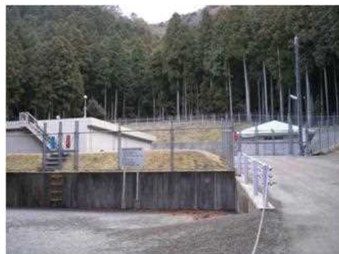
大久保第2配水池
