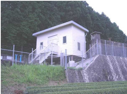
小岐須第1・第2配水池
