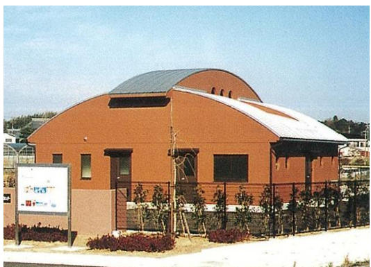
御菌地区浄化センター
