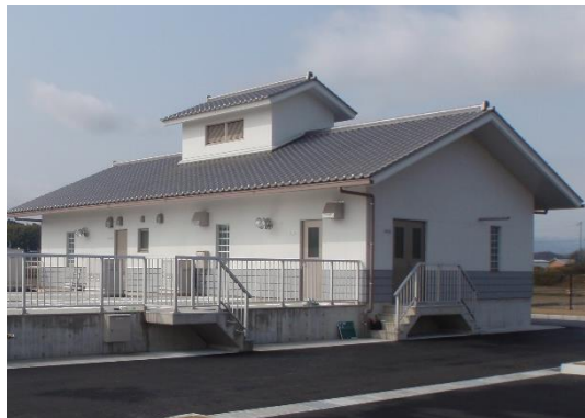
三宅・徳居地区浄化センター
