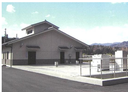
東庄内地区浄化センター
