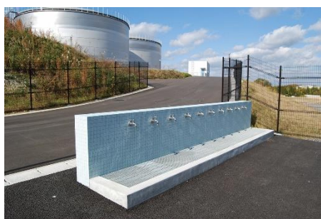
国府第2配水池
