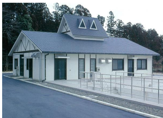
下大久保地区浄化センター
