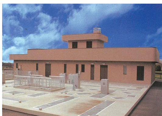
伊船・長澤地区浄化センター
