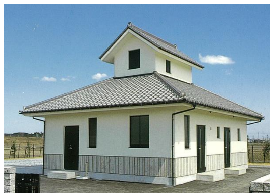
甲斐地区浄化センター
