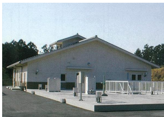
椿地区浄化センター
