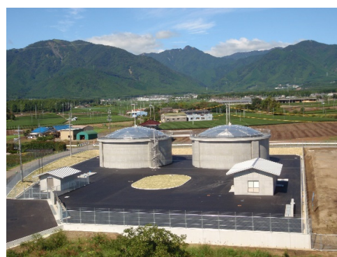
椿 一 宮 配 水 池
