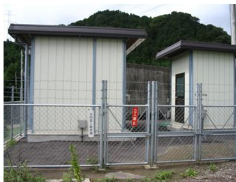
庄内第1配水池
