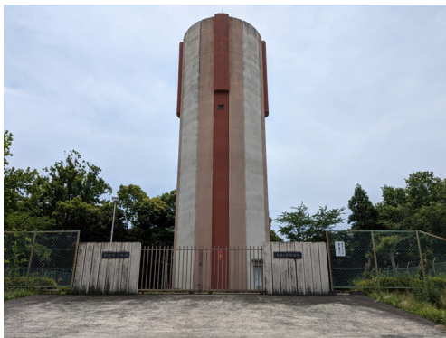
太陽の街配水塔
