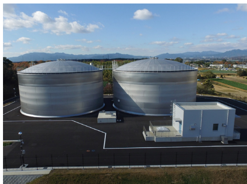
国府第 2 配水池
