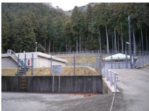
大久保第 2 配水池
