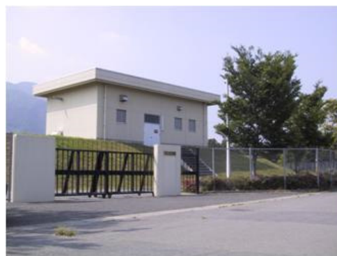
大久保第 1 配水池
