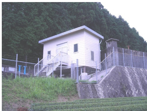
小岐須第1・第2配水池
