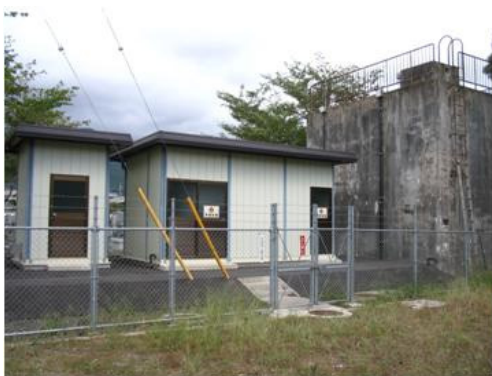
庄内第2配水池
