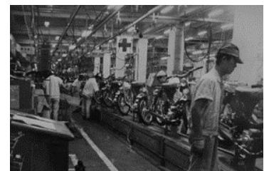
オートバイ組立工場 (1961年頃)
