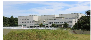
不燃物リサイクルセンター
