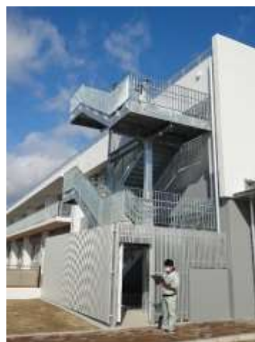
津波避難施設
