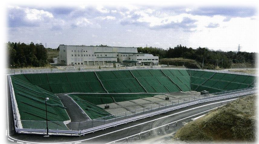
【最終処分場（上中谷埋立処分地）】
