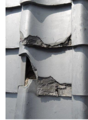
瓦が著しく破損している例
