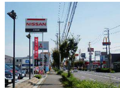
(都)鈴鹿中央線(三日市・西条付近)沿いの景観
