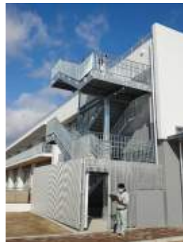
津波避難施設
