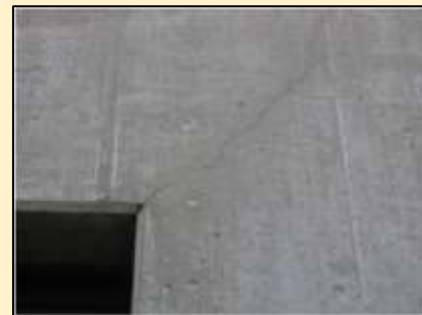
【コンクリートの乾燥収縮ひび割れ】
