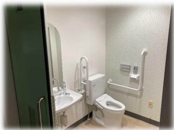
多目的トイレの整備
