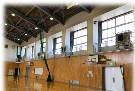
空調設備の整備
