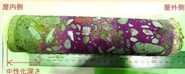
【コンクリートの中性化深さ】
