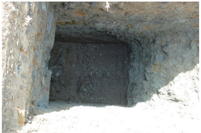
写真10 f地点掘削状況(南から)
