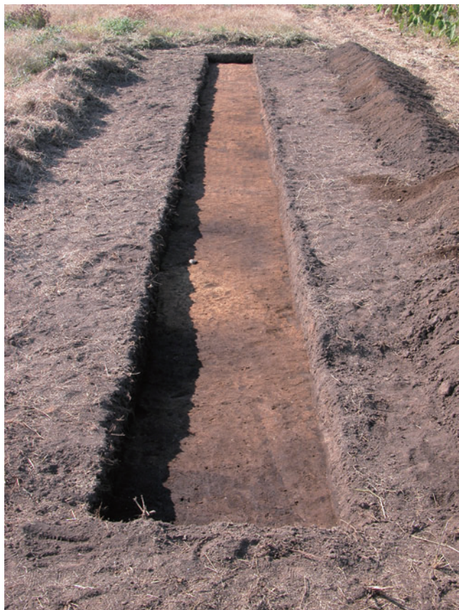
写真1 1トレンチ掘削状況（東から）
