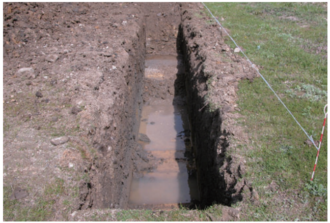
写真6 b-1地点掘削状況(西から)
