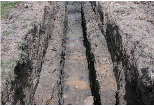
写真5 a-1地点掘削状況(南から)
