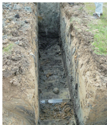
写真12 g地点掘削状況(北から)
