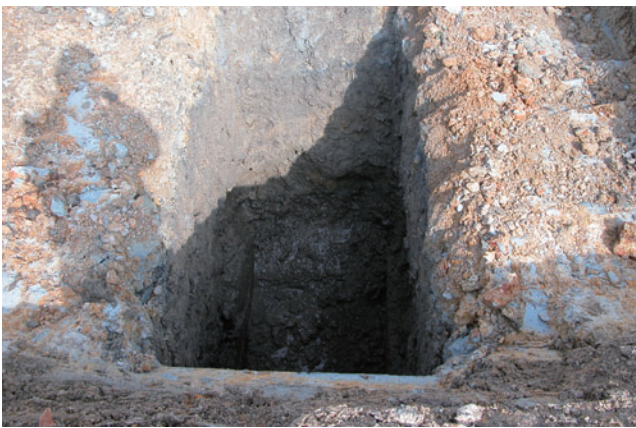
写真7 c-1地点掘削状況(南から)
