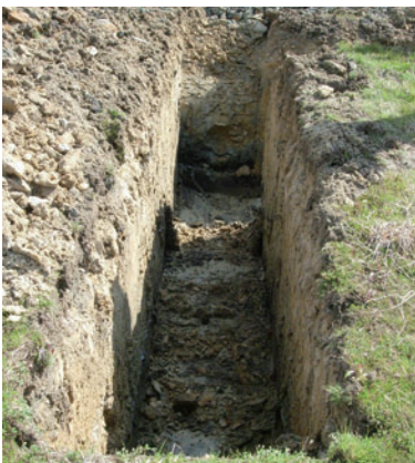
写真11 g地点掘削状況(西から)
