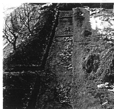
6AIF-A 区全景（東から）
