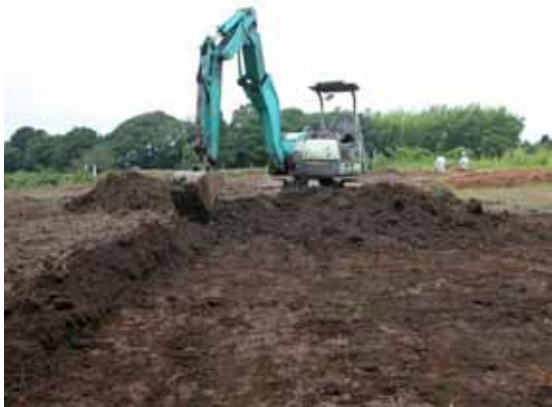
写真2 表土除去の様子(北から)
