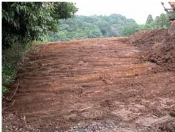
写真3 重機掘削後の様子(西から)
