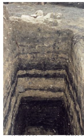
後殿基壇の断面(版築)
