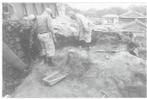
調査風景 (煙出し付近)
