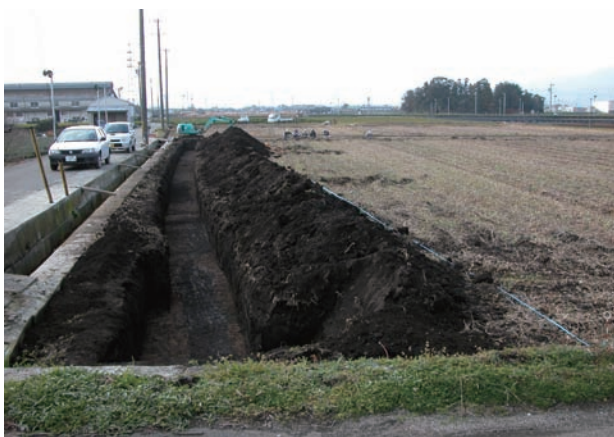
写真 28 東西トレンチ掘削状況（東から）
