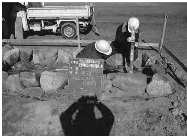
碑 2 (説明版) 基礎施工 (南から)
