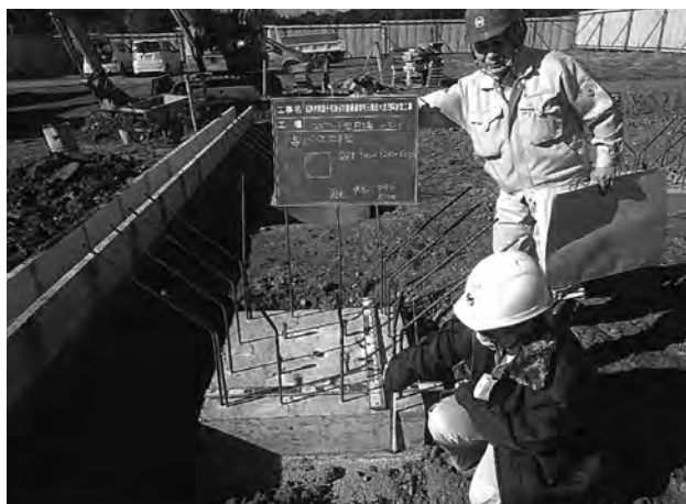
コンクリートベース（西から）
