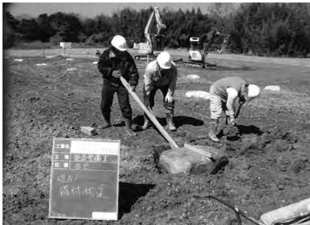
講堂基壇上礎石据え付け施工中 (東から)
