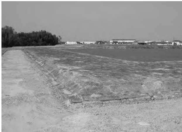
西回廊基壇施工完了 (南から)
