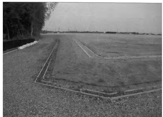
雨水排水工（北西隅部 U 字溝設置）（西から）
