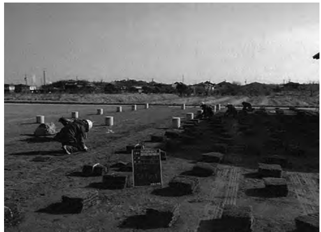
東南部芝舗装作業 (西から)
