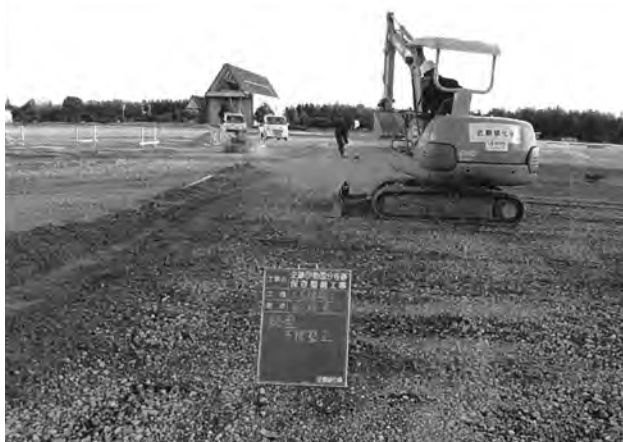
講堂・僧坊間土舗装路盤工 (北から)
