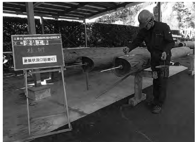
塗装作業 2 回目
