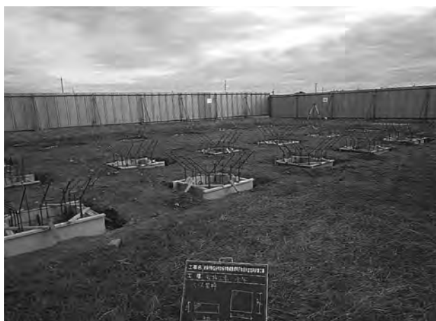
ベース型枠配置（南東から）
