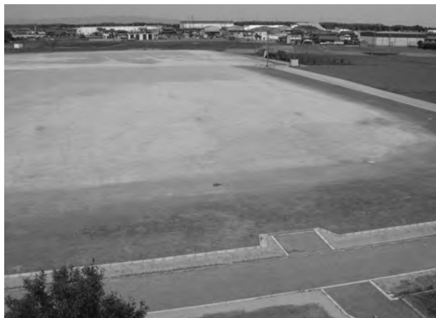
施工後全景：東半（南から）
