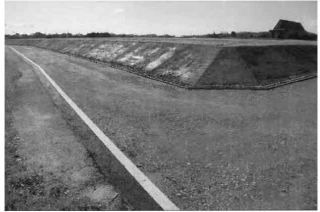
広場整備工（北東部盛土・路盤）（北東から）
