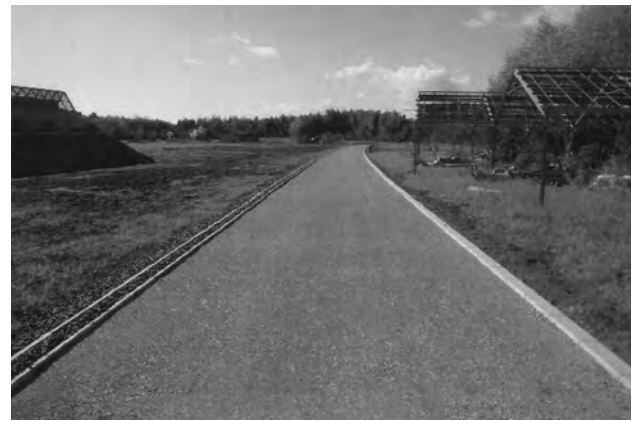
園路整備工（西辺部路盤）（北から）
