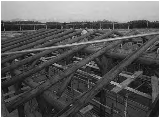
建方作業 (東から)
