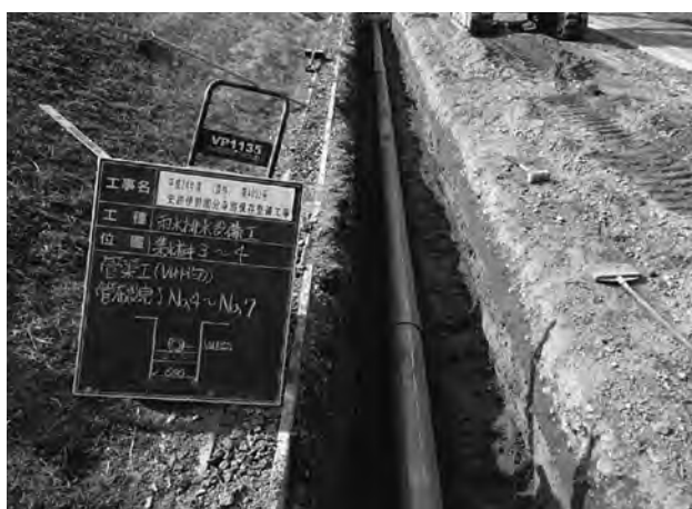
北辺外周路雨水排水管敷設 (東から)
