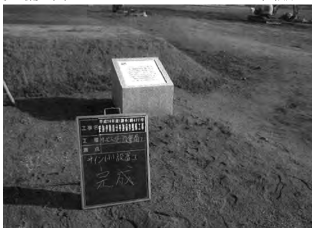
中門サイン (小) 設置完了 (南から)
