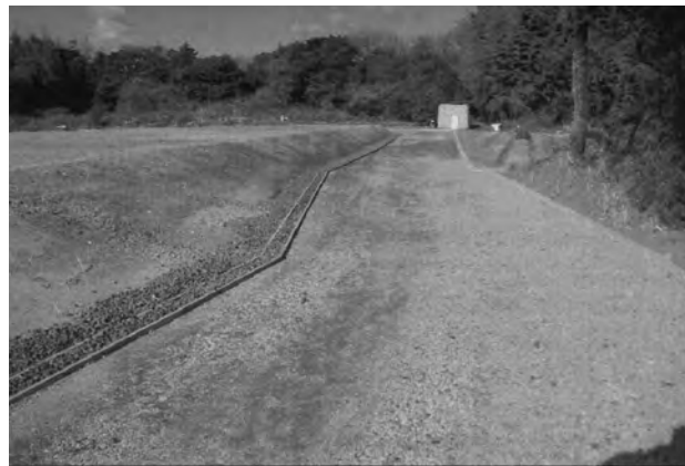
園路整備工（北辺部路盤）（東から）
