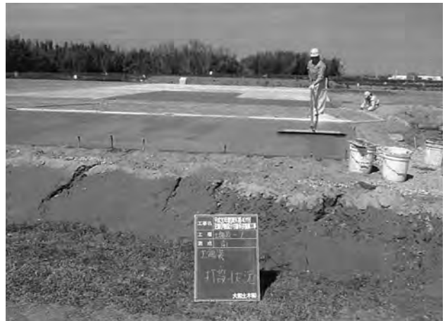
南門付近土舗装 (南から)
