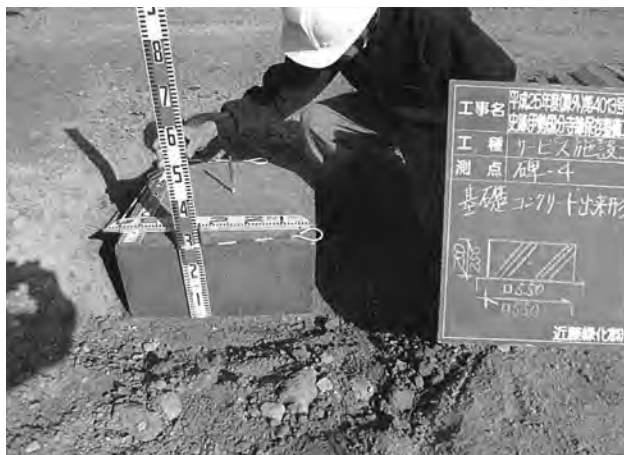
碑 4 (廻国碑) 基礎施工 (南から)
