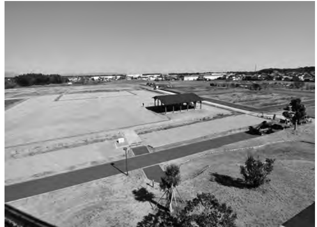
施工後全景：東半（南から）
