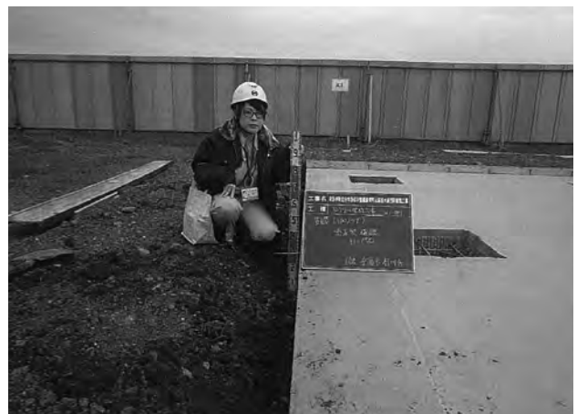
基礎スラブ打設完了 (南から)
