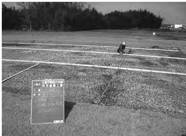
講堂・僧坊間土舗装目地打ち (南から)
