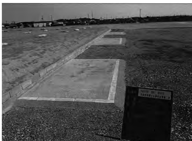
講堂南面階段施工完了 (西から)
