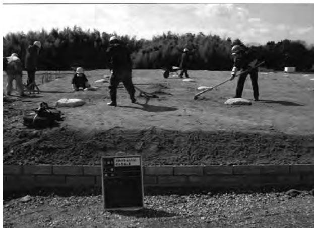
講堂基壇上目砂敷き均し作業 (東から)
