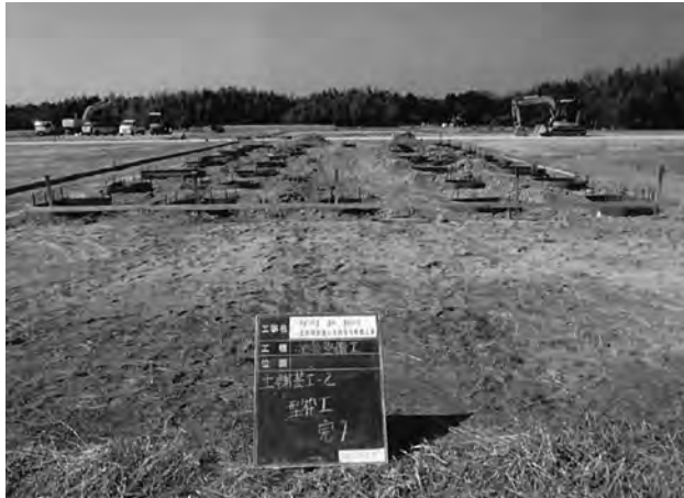
食堂壺地業内土舗装 (東から)
