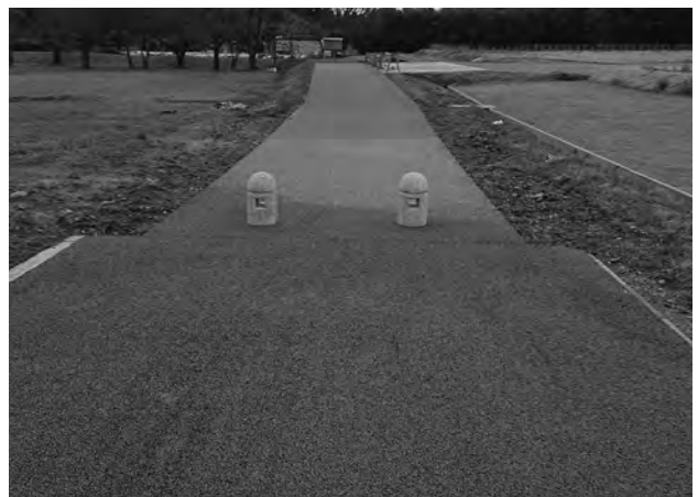
南辺外周路自然色アスファルト舗装（東から）
