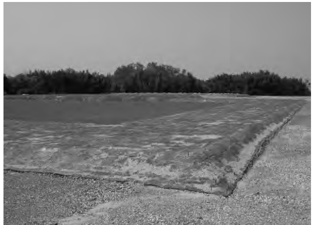
東回廊基壇施工完了 (南から)
