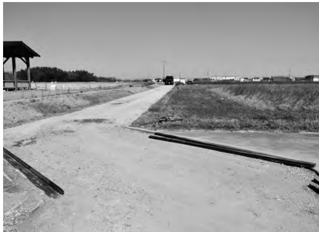
東辺外周路路盤工（東から）
