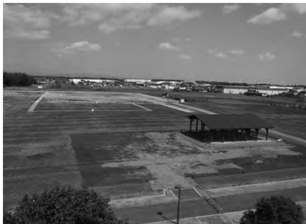
施工後全景：東半（南から）
