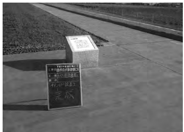
南東隅建物回廊サイン (小) 設置完了 (南から)
