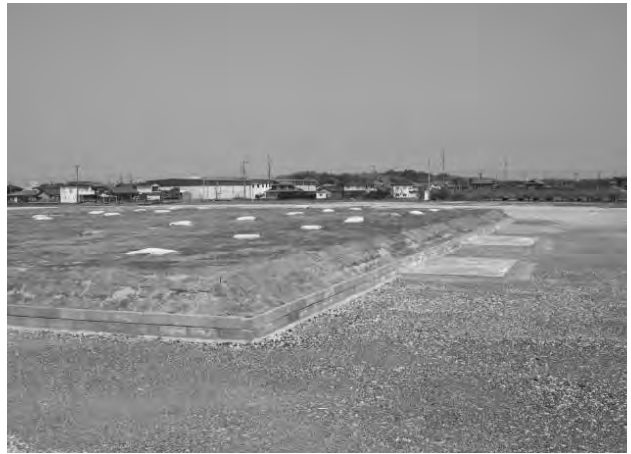
講堂基壇施工完了（南西から）
