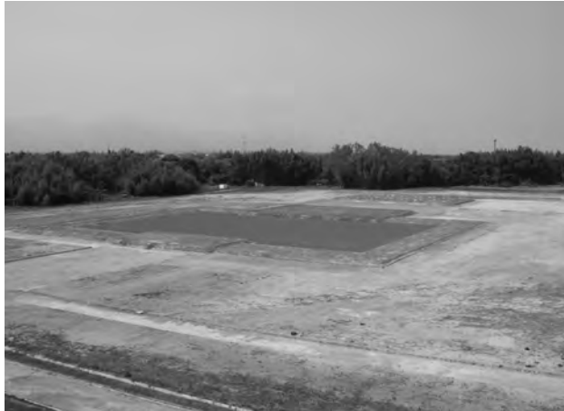
施工後全景：西半（南から）
