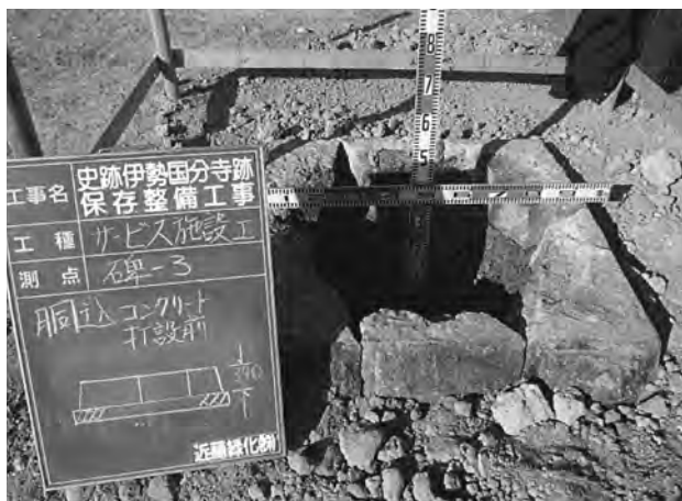
碑 3 (標石) 基礎施工 (南から)
