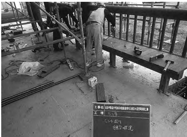
ベンチ組み立て作業
