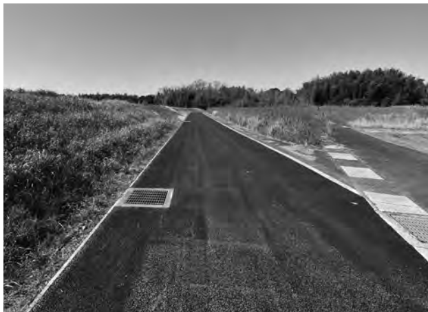
北辺東部外周路透水性アスファルト舗装（東から）
