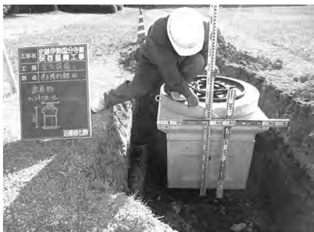
電気設備工 (給電用ハンドホール設置作業)
