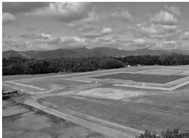
施工後全景：西半（南から）
