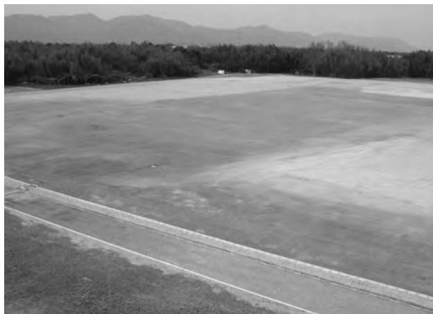
施工後全景：西半（南から）
