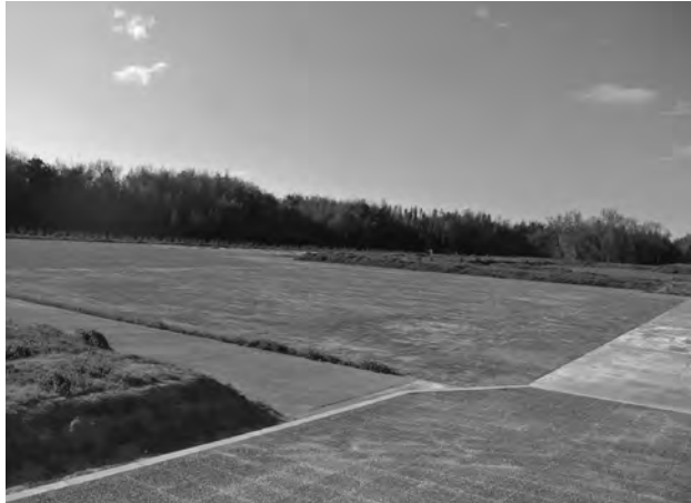
施工後全景：西半（南から）
