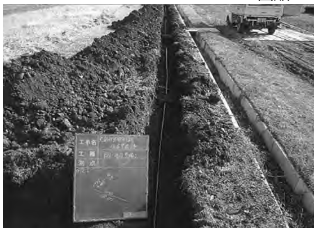
給水設備工 (水道管布設作業) (西から)
