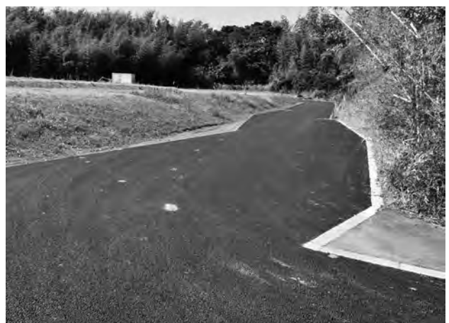
北辺西部外周路透水性アスファルト舗装（東から）
