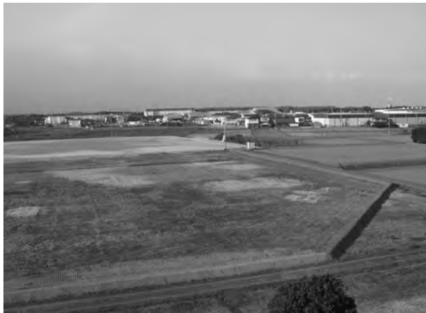
施工後全景：東半（南から）
