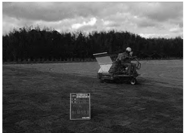
西南部芝舗装目土散布作業 (南東から)
