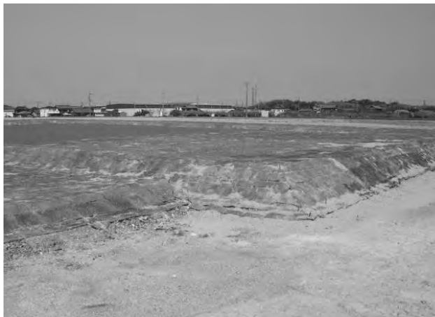
中門基壇施工完了 (南西から)
