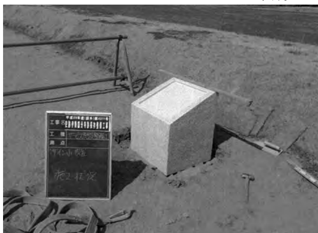
南門サイン (小) 台石設置作業 (南から)
