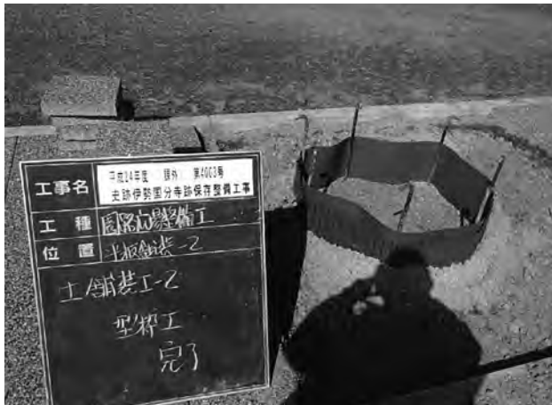
小院南門柱穴土舗装 2 (南西から)
