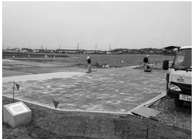
南門作業風景（南西から）
