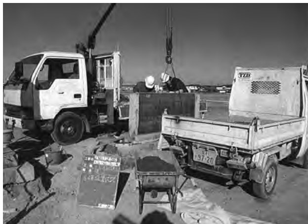
碑 2 (説明版) 設置作業 (南西から)
