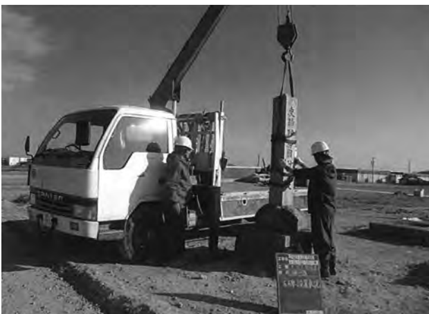
碑 3 標柱設置作業 (南から)
