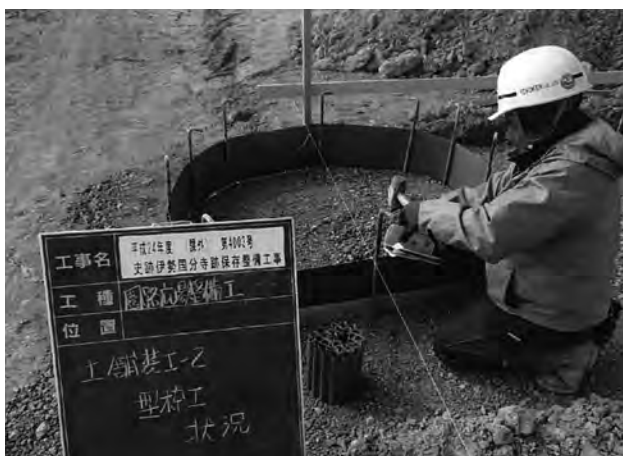
食堂壺地業表示型枠工
