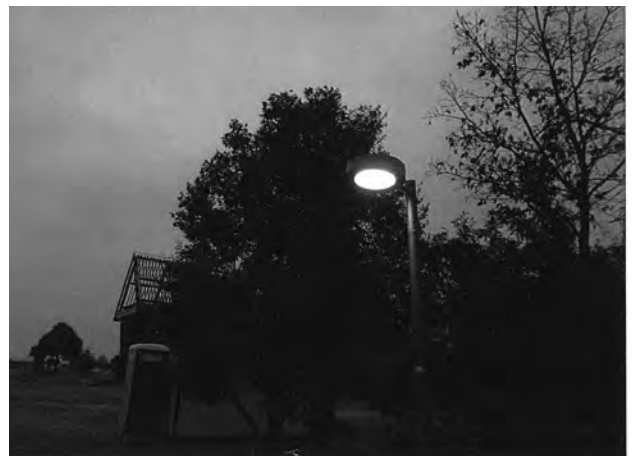
電気設備工 (照明灯点灯) (西から)
