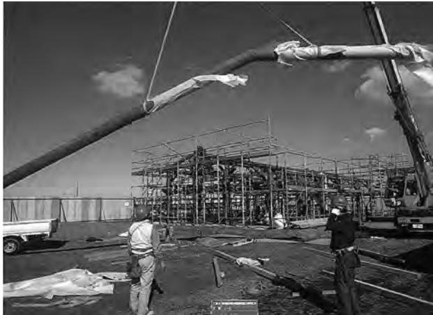
掘立柱建物 (南棟) 登り梁建方作業 (西から)
