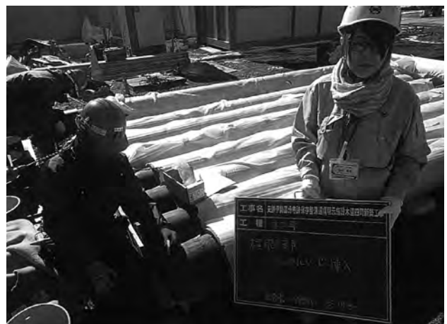
防腐剤挿入作業
