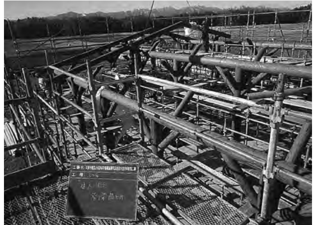
登り梁建方 (東から)
