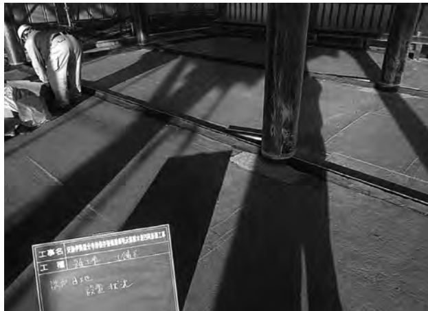
土舗装打設目地打ち作業
