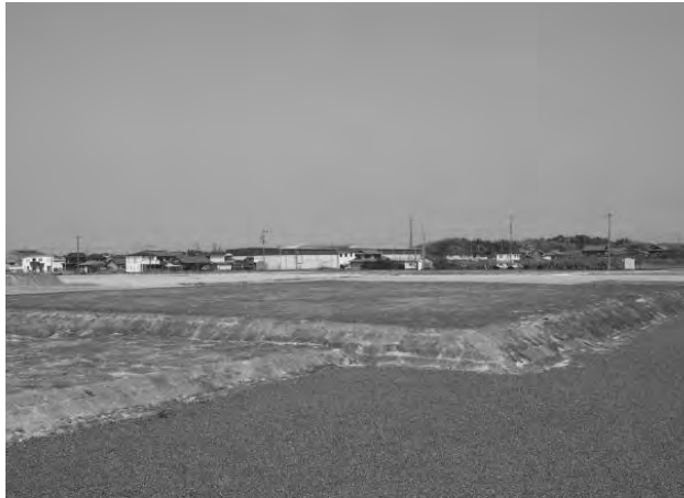
金堂基壇施工完了 (南西から)
