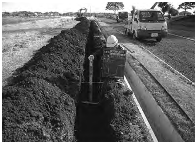
給水設備工 (水道管布設作業) (西から)
