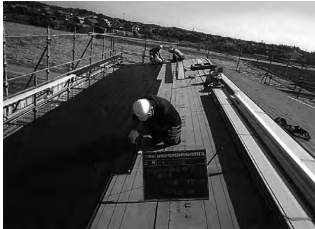
掘立柱建物（南棟）ガルバリウム鋼板葺き作業
