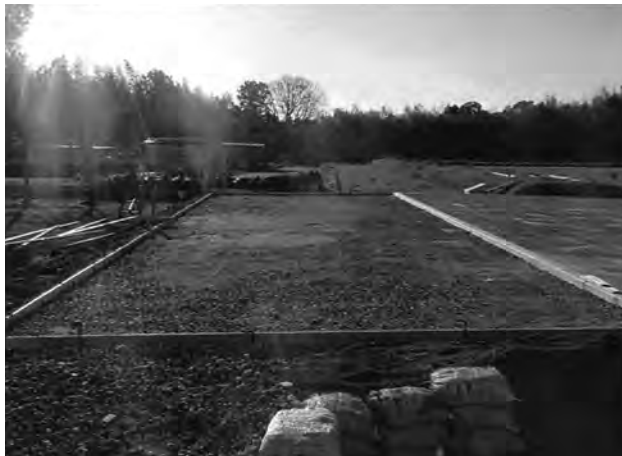
南門南土舗装目地打ち (東から)
