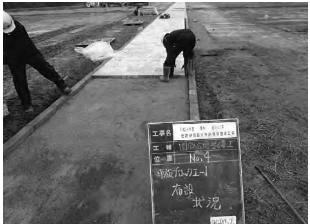
北東院西辺築地平板舗装敷設 (北から)
