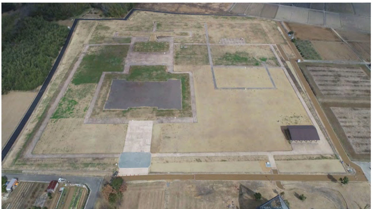
全景（南から） 令和 2 年 3 月 2 日撮影 提供：株式会社シー・ティー・ワイ/ケーブルネット鈴鹿
