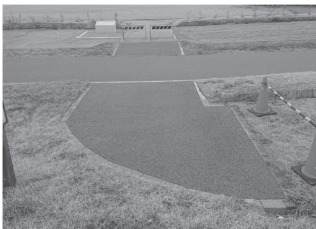
東南部アプローチ自然色アスファルト舗装 (南から)
