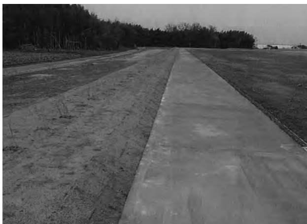
西辺築地表示と内部の土舗装（南から）
