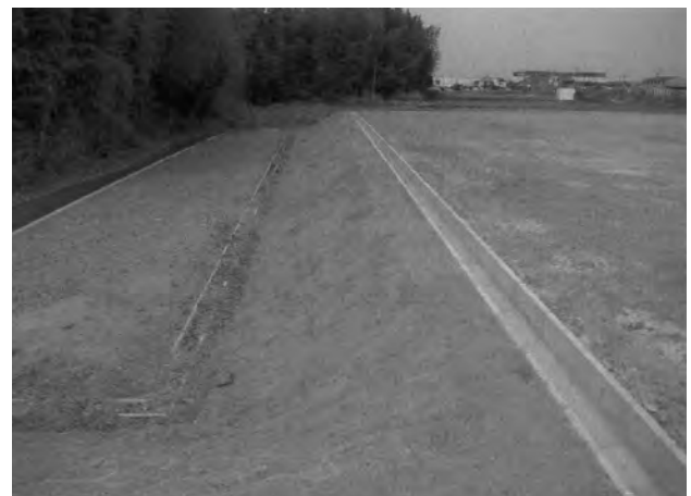
排水整備工（北西部 U 字溝設置）（南から）
