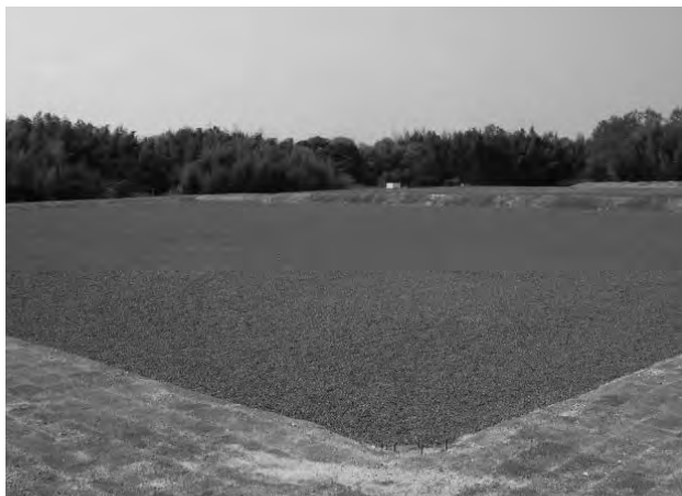
回廊内砂利舗装 (南東から)
