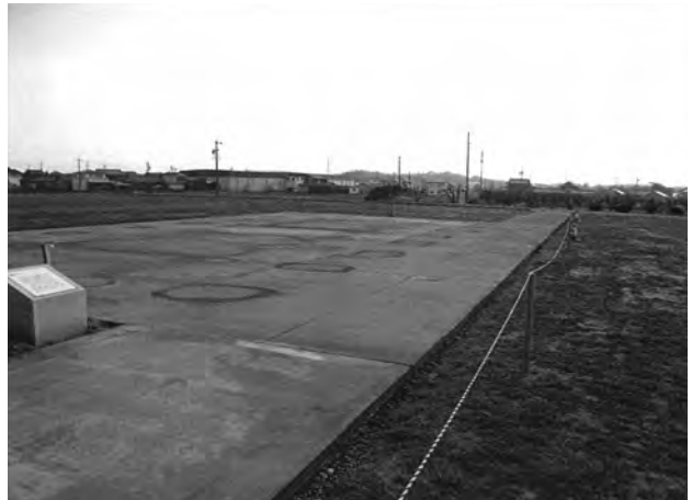
食堂土舗装完了（南西から）
