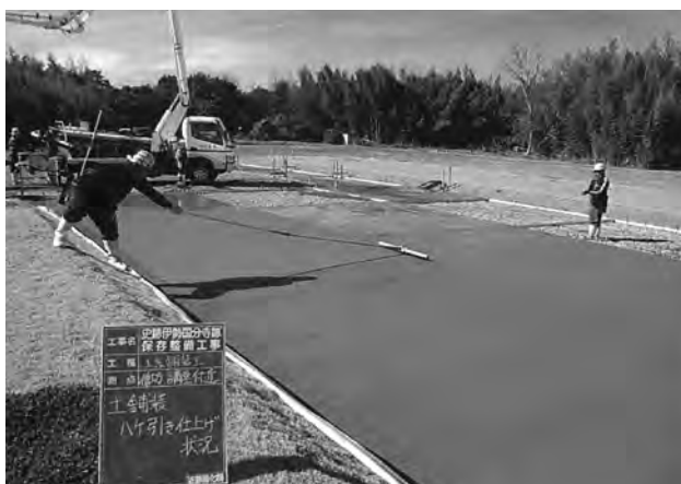
講堂・僧坊間土舗装打設 (南東から)
