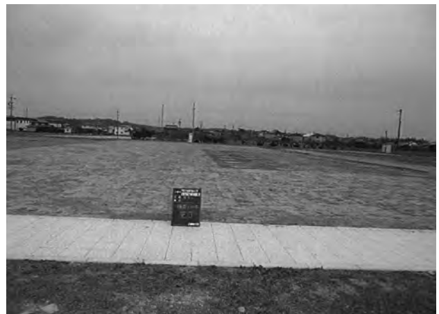
伽藍地東北部芝舗装完了 (西から)
