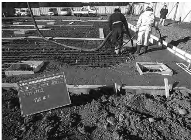
基礎スラブコンクリート打設作業 (東から)
