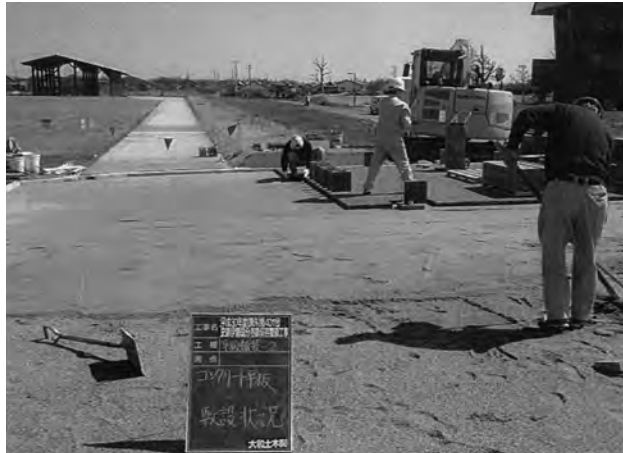
南門表示上面平板舗装作業 (西から)
