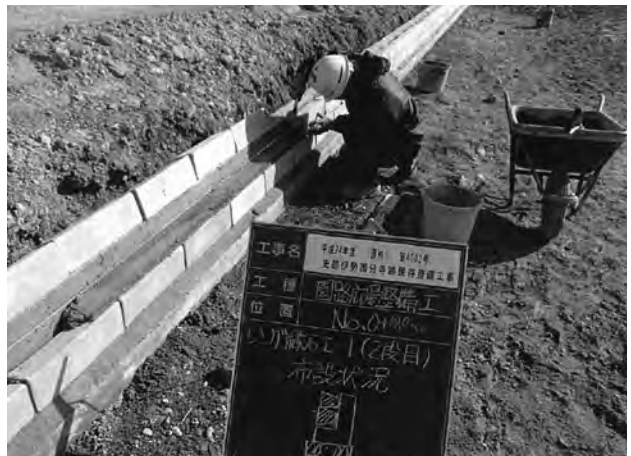
講堂塙積施工中 (西から)
