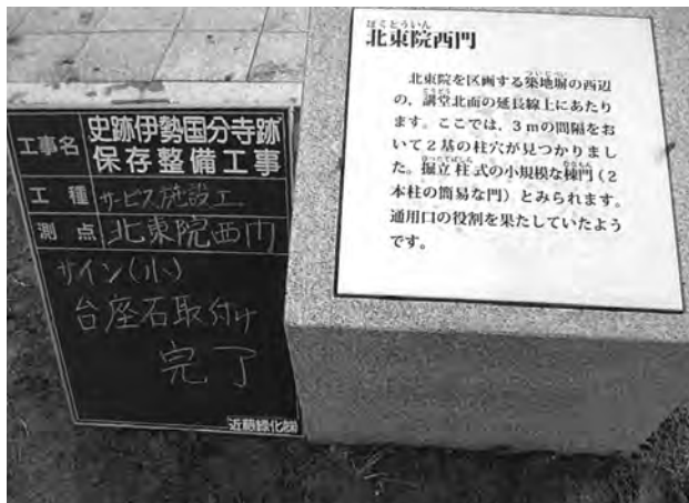
北東院西門サイン (小) 設置完了 (西から)
