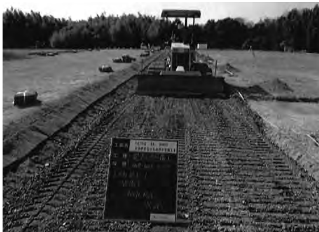
僧坊北辺土舗装路盤工 (東から)
