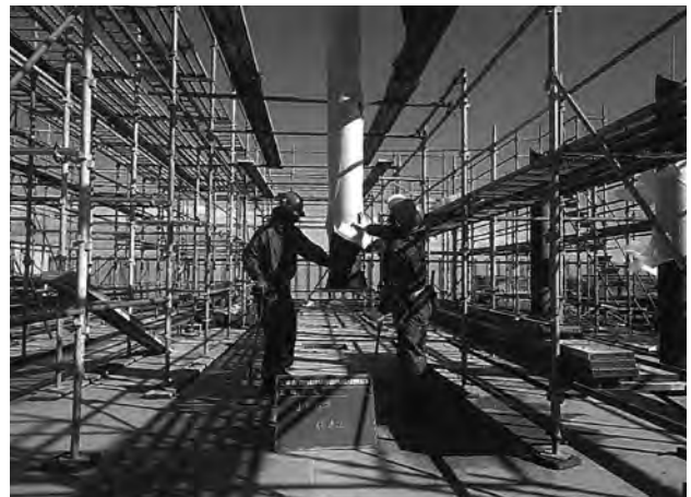
柱建方作業 (西から)
