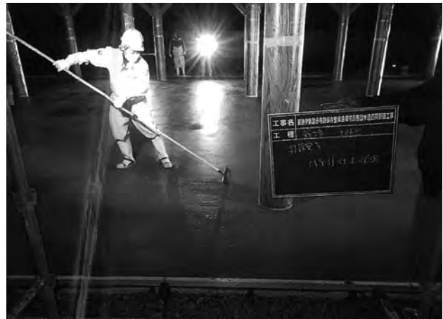
土舗装打設作業
