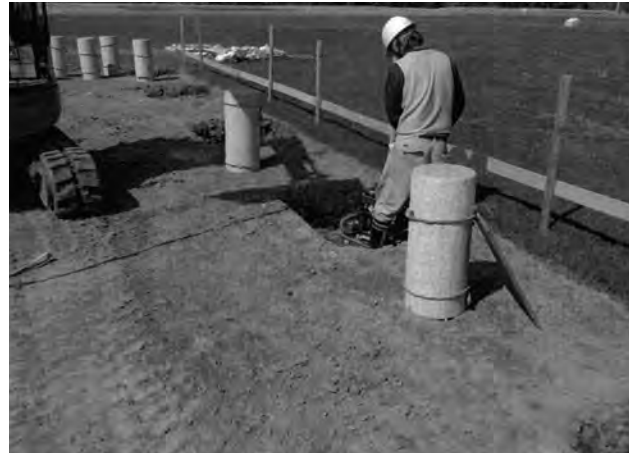
スツール基礎打筋 (東から)
