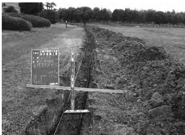
電気設備工 (配電管敷設) (北から)
