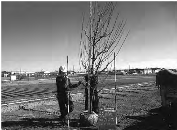
植栽工 (植栽苗検査) (南西から)
