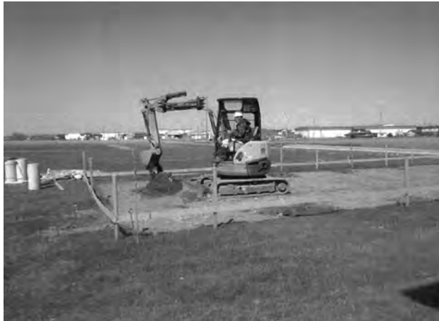
掘立柱建物 (北棟) 表示兼スツール整地作業 (南から)
