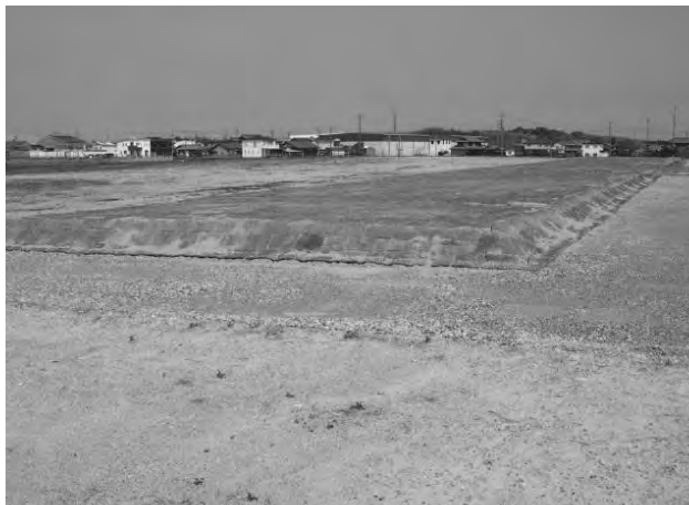
僧坊基壇施工完了（西から）
