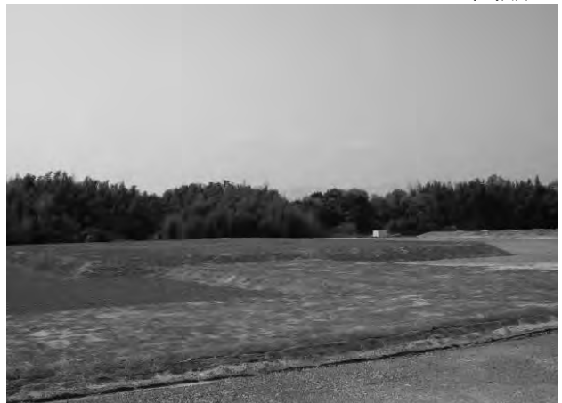
金堂・東回廊基壇施工完了 (南東から)
