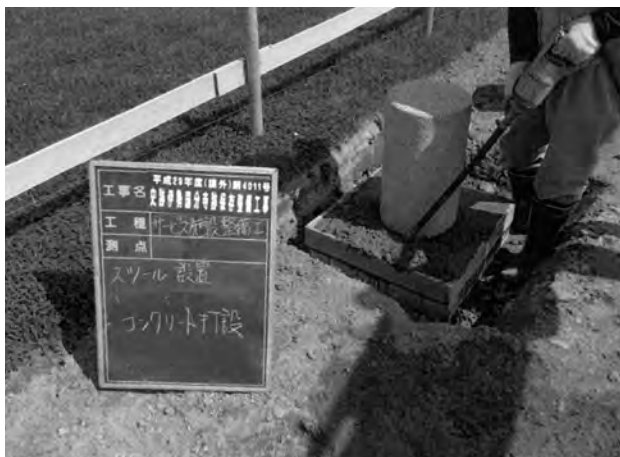
スツール設置作業 (西から)
