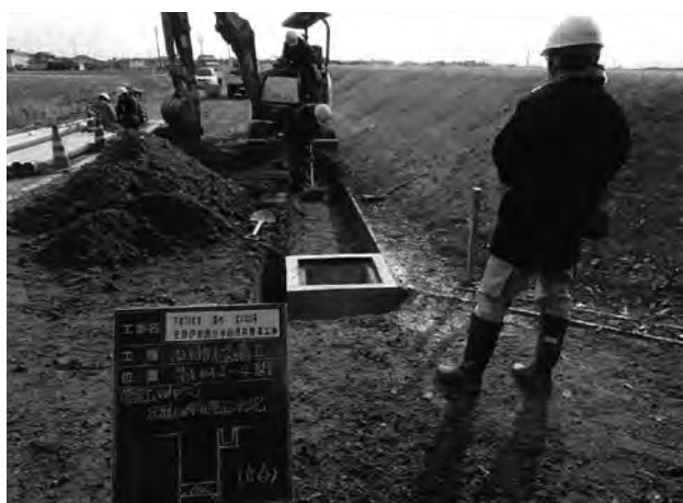
北辺外周路雨水排水工事立合調査風景 (西から)
