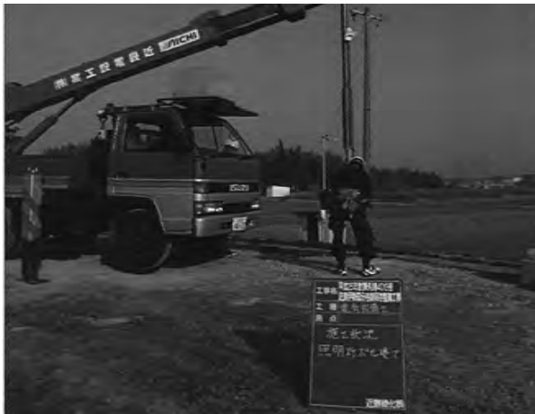
電気設備工 (照明灯設置)
