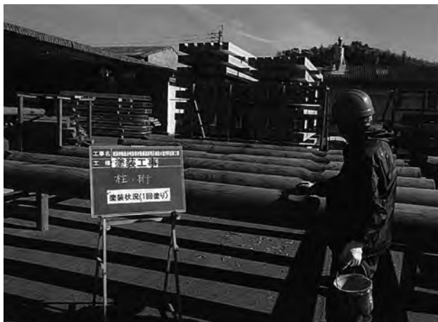
塗装作業 1 回目
