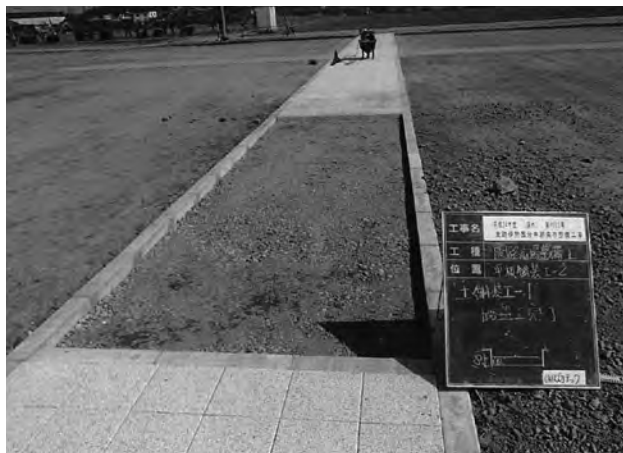
北東院南門土舗装 2 路盤工 (西から)
