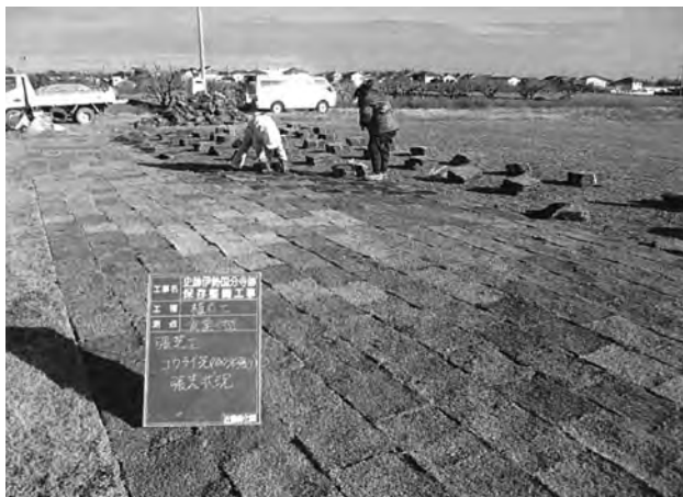
伽藍地東北部芝舗装作業 (西から)
