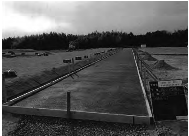
僧坊北辺土舗装施工完了 (東から)
