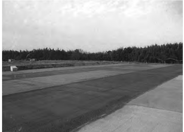
金堂・講堂間土舗装（北東から）
