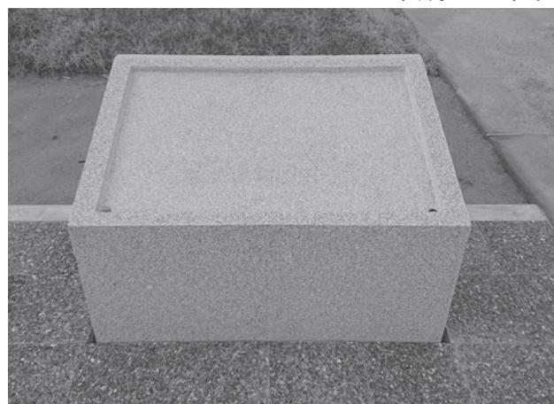
東南部サイン (大) 基礎 (南から)
