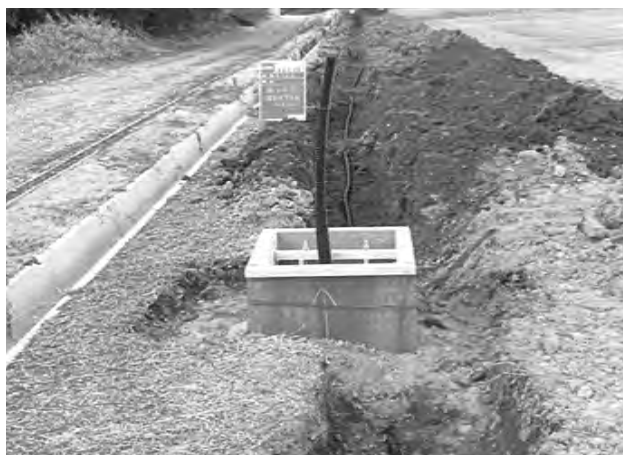
電気設備工 (照明灯アンカーボルト) (南から)
