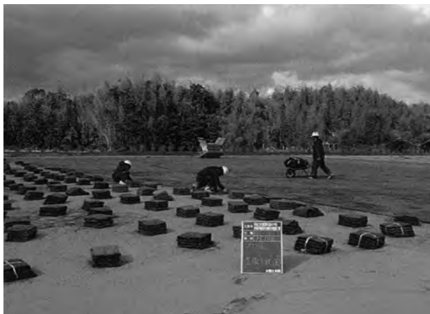
西南部芝舗装作業 (東から)
