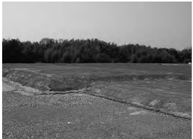
中門基壇施工完了 (南東から)
