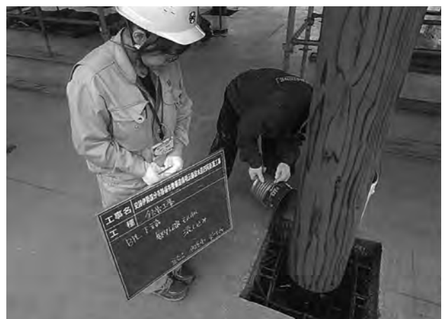
柱底コンクリート流し込み
