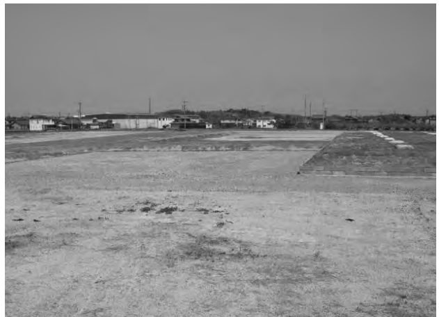
軒廊基壇施工完了（西から）
