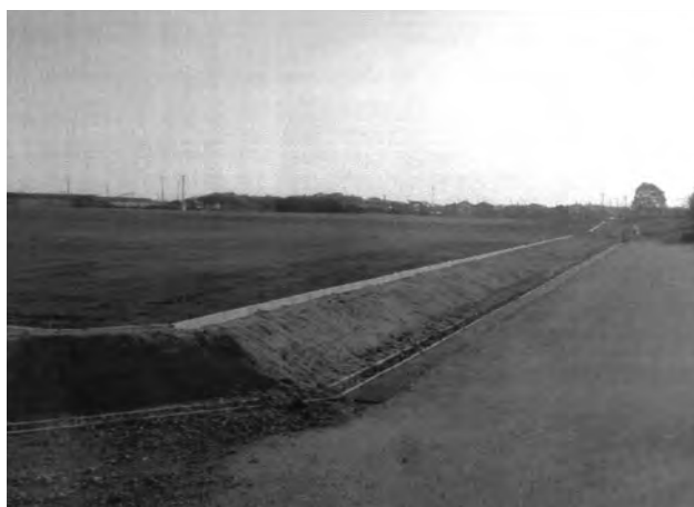
広場整備・雨水排水工（南部）（西から）
