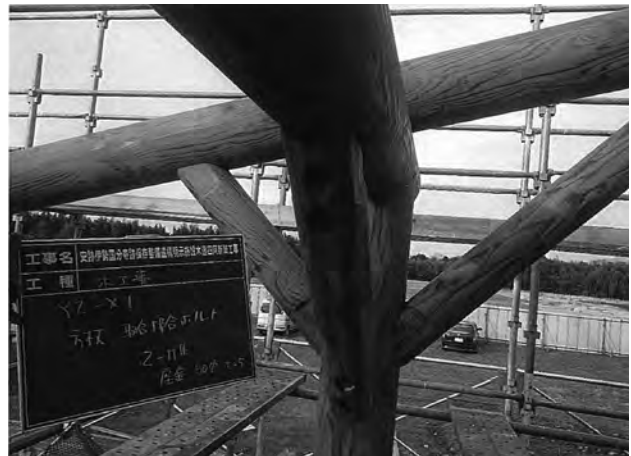
方杖ボルト接合状況
