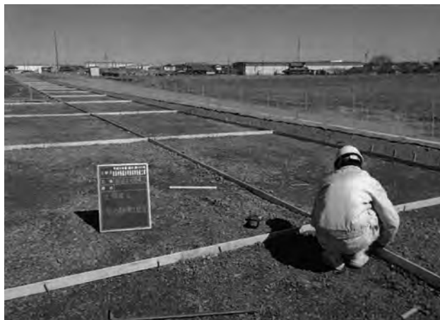
掘立柱建物 (南棟) 付近土舗装目地打ち (南から)
