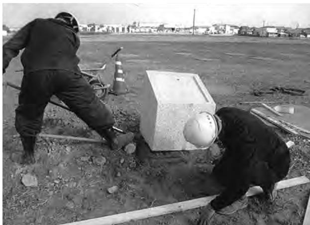
食堂サイン (小) 台石据え付け作業 (南から)
