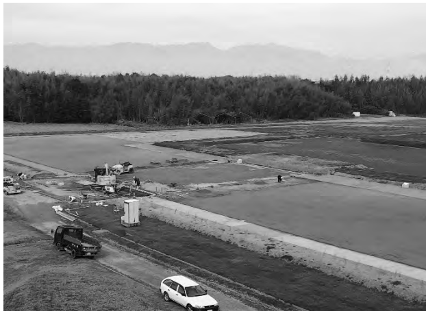
南門付近工事風景（南東から）
