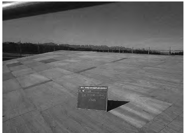
屋根野地板取り付け完了
