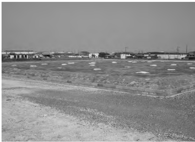
講堂基壇施工完了（南西から）
