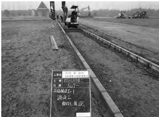
北東院西辺築地平板舗装路盤工 (北から)
