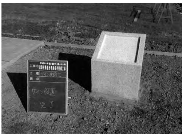
サイン (小) 台石設置 (南から) 南東隅建物
