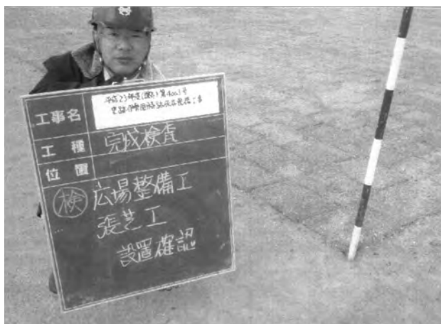
園路広場工（芝舗装）
