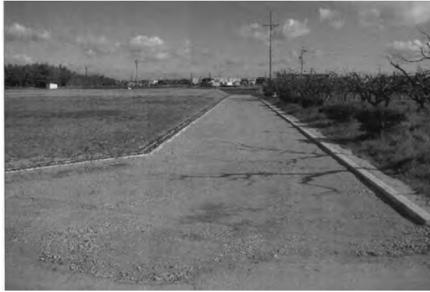
園路整備工（東辺部路盤）（南から）
