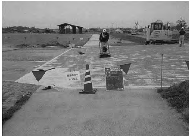
南門表示上面平板舗装転圧作業 (西から)
