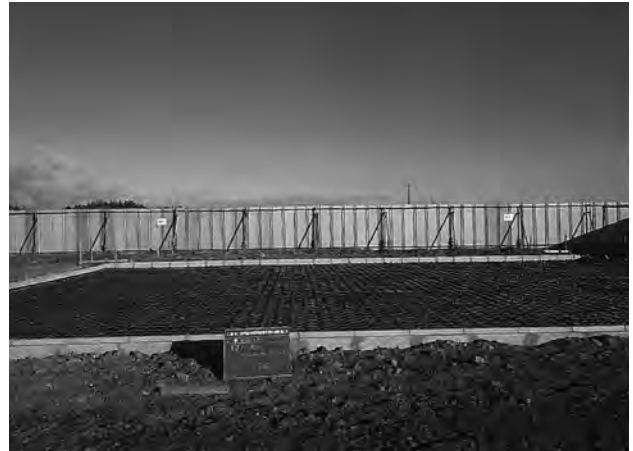
基礎スラブ配筋 (南から)
