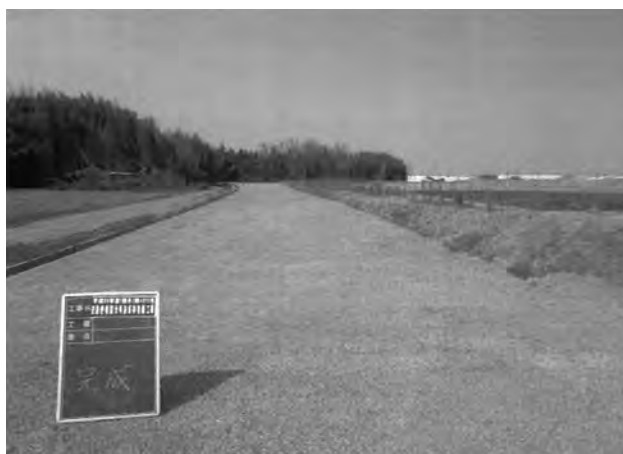
西辺築地外の芝舗装 (南から)
