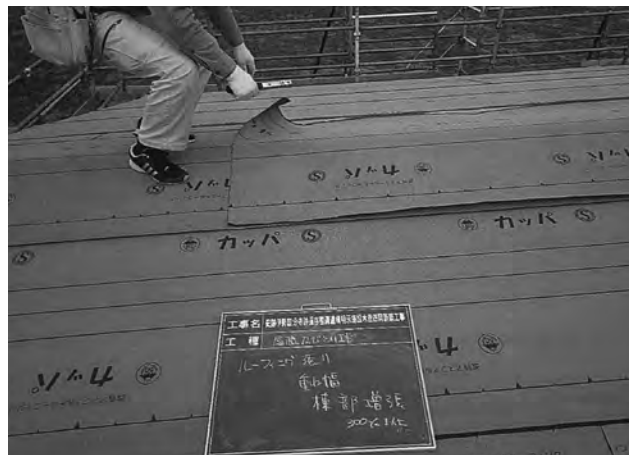
ルーフィング貼り付け作業
