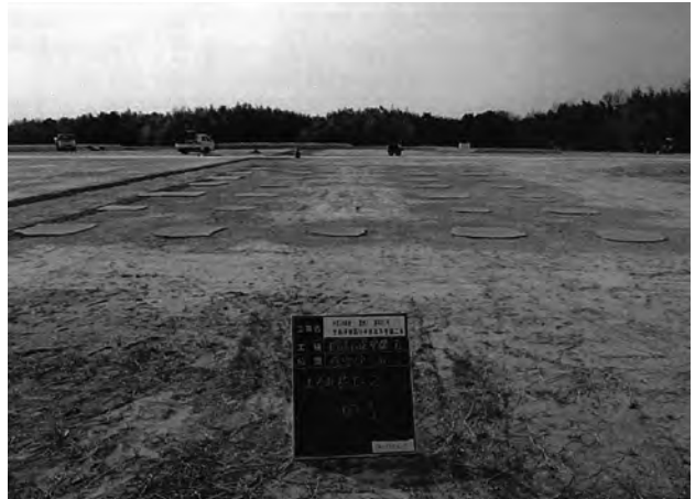
食堂壺地業土舗装施工完了 (東から)
