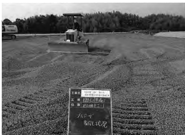
回廊内砂利舗装施工中 (東から)
