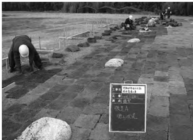
講堂芝張り作業 (東から)
