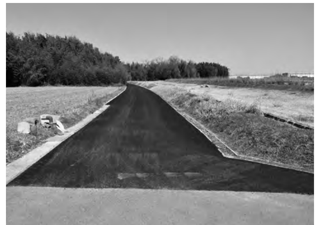
西辺外周路透水性アスファルト舗装（南から）
