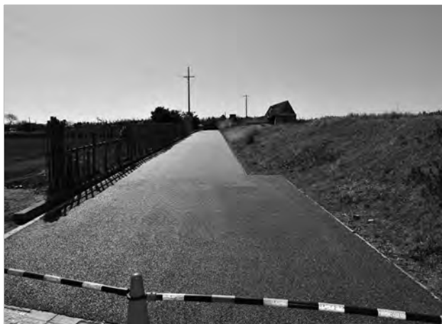
東辺外周路自然色アスファルト舗装（北から）
