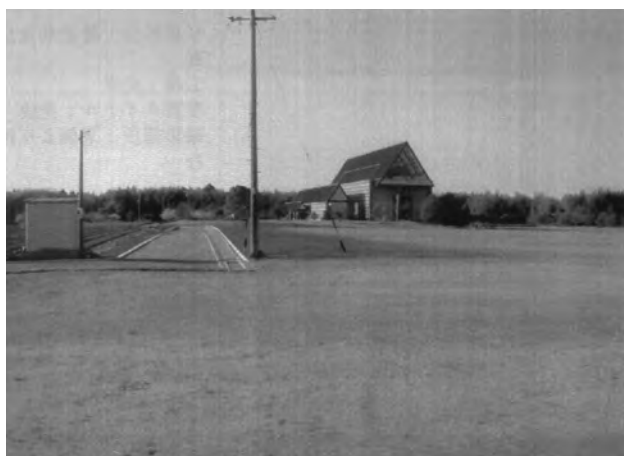
広場整備工（東辺部路盤）（北から）
