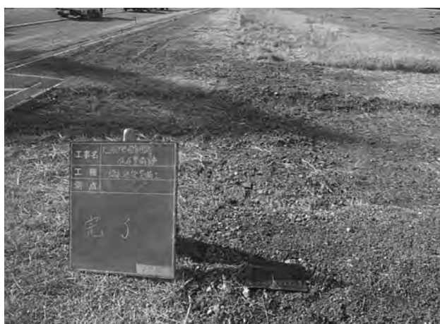
給水設備工 (給水栓設置完了) (東から)
