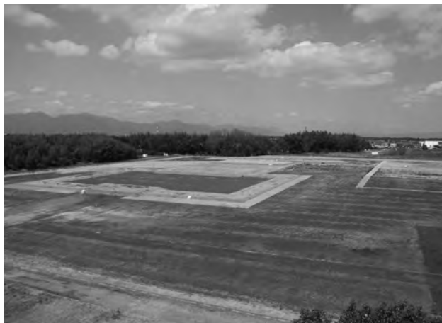
施工後全景：西半（南から）
