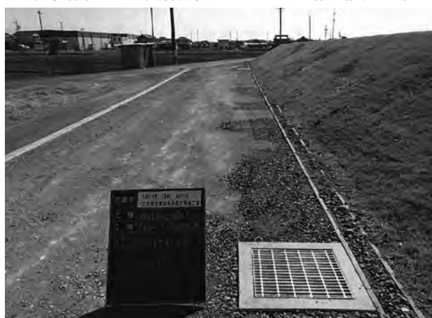
北辺外周路雨水排水管柵 (東から)
