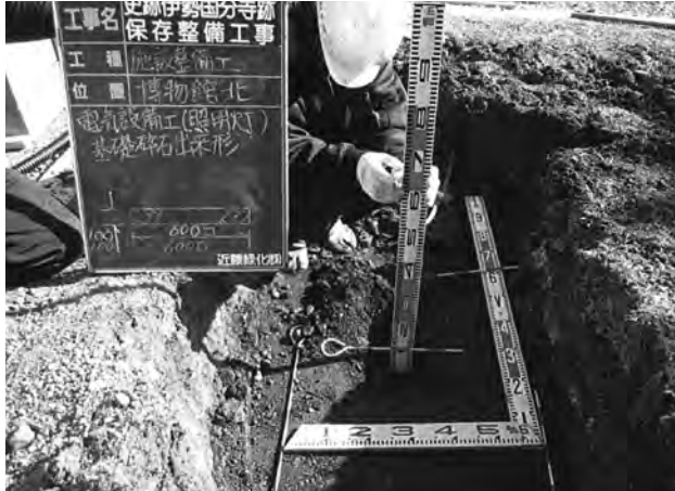
電気設備工 (照明灯基礎施工)
