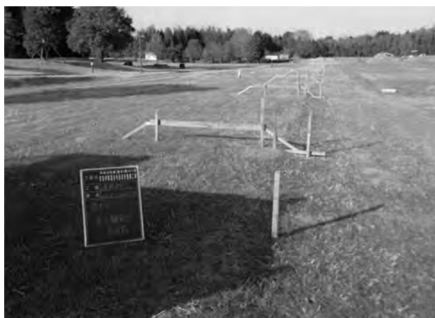
南辺築地表示のため丁張 (東から)
