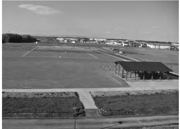
施工後全景：東半（南から）
