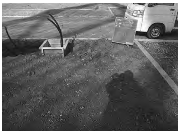
給水設備工 (止水栓設置完了) (西から)
