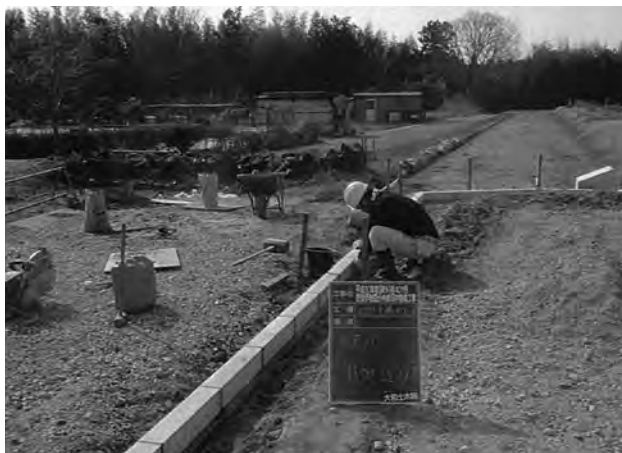
南門表示地先境界ブロック（東から）
