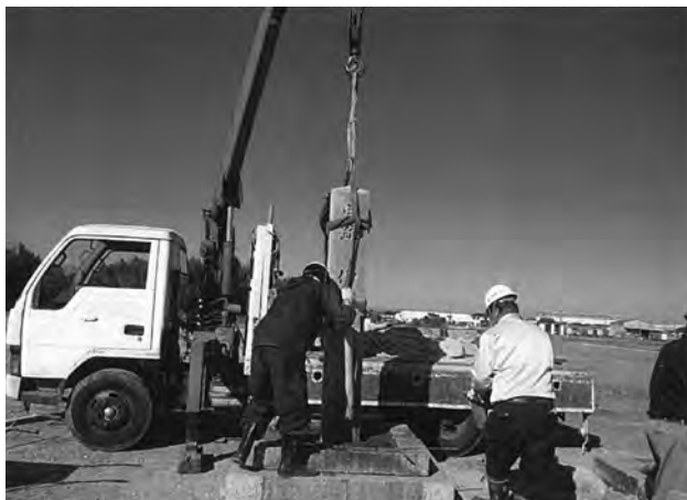
碑 1 (標石) 設置作業 (南から)
