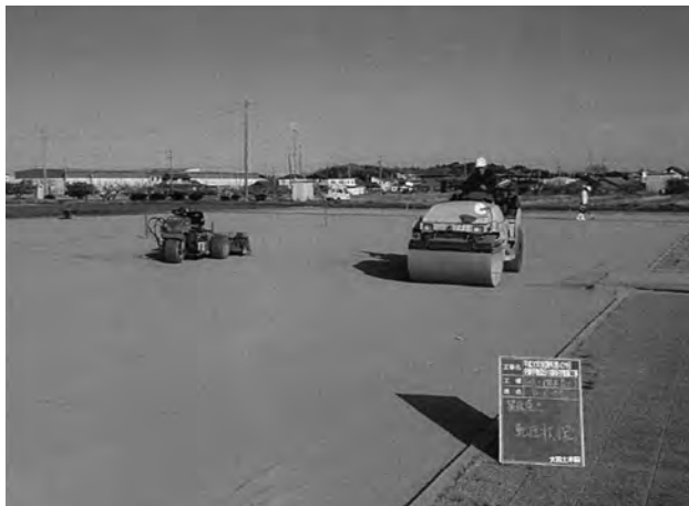
東南部芝張り床土転圧 (西から)
