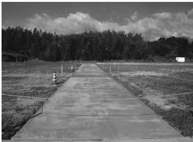
講堂 - 西辺築地間土舗装（東から）
