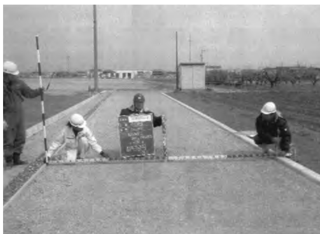
園路整備工（東辺部路盤）（南から）
