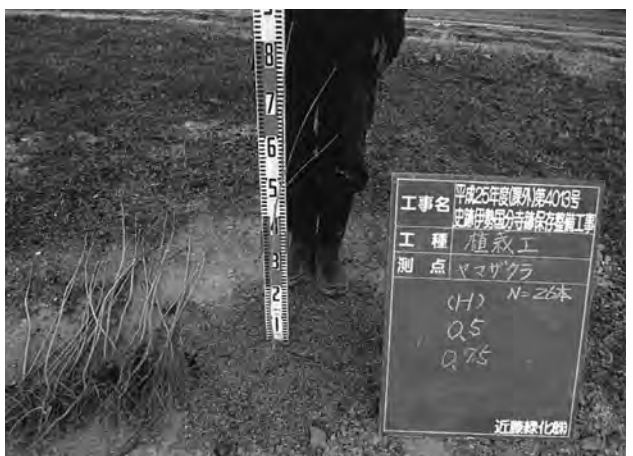
植栽工 (植栽苗検査)
