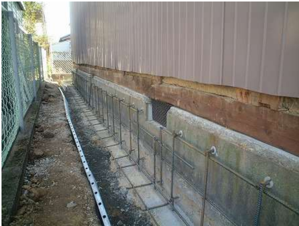
図－15 耐震補強工事の状況
