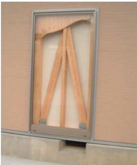
図－16 補強方法の啓発のためのスケルトン構造の例
