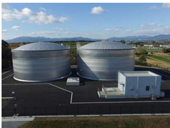
【国府第 2 配水池】
