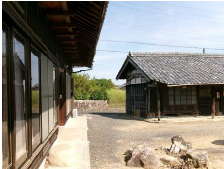
【道路からの進入口】
