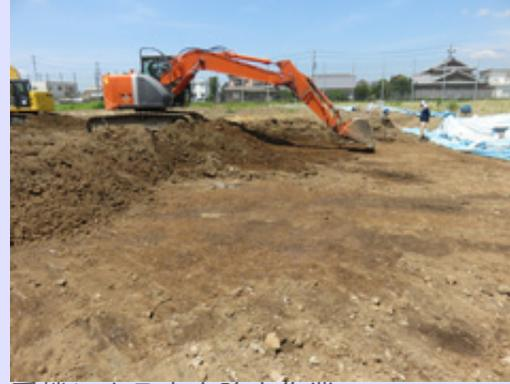
重機による表土除去作業
