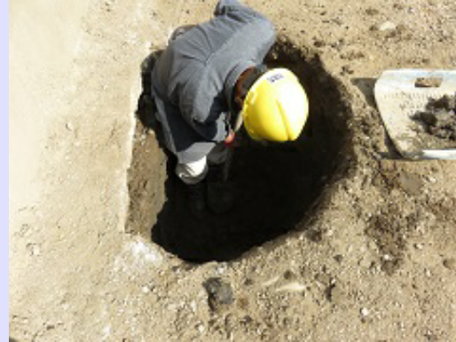
校舎の基礎の下からも井戸が見つかります
