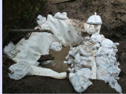
護岸施設と底面を保護しつつ埋め戻し
