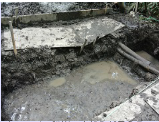
1トレンチ，護岸の木組みが見える
