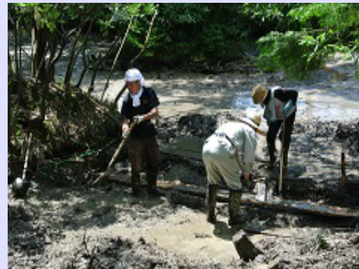
掘削作業風景
