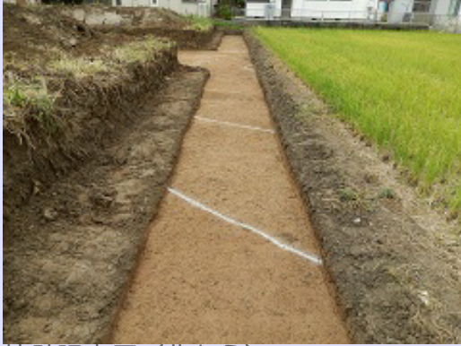
擁壁調査区（北から）
