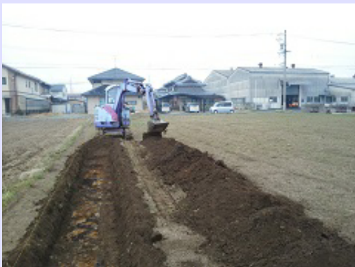
重機による表土除去（東から）
