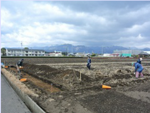
作業風景（東から）
