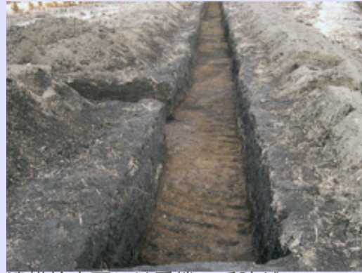
遺構検出面には重機の爪跡が・・・
